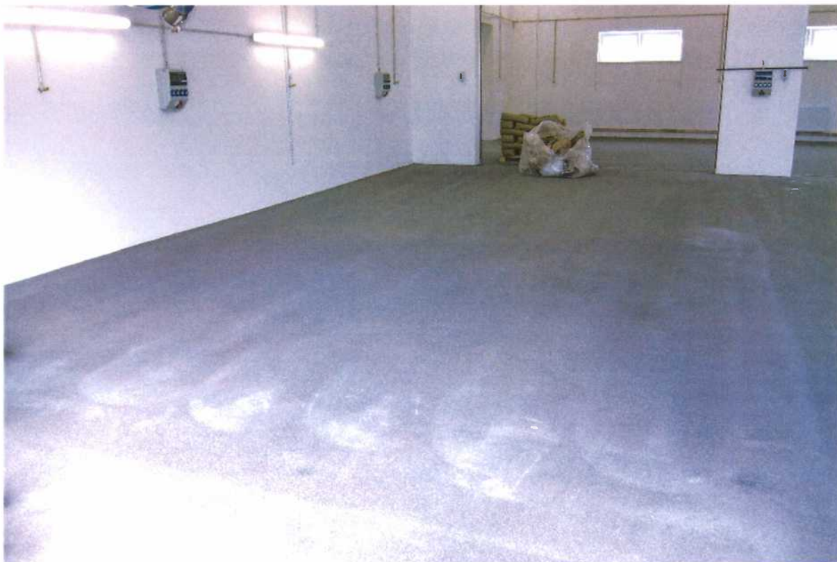
Instalovaný rozvod tlakového vzduchu v objektu:
