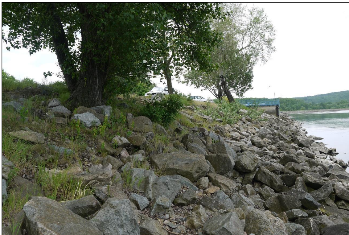
Opevněný břeh v místě návrhu nového sjezdu – pohled směrem k výpustnému objektu a konci hlavní hráze (nebudou stavbou dotčeny)
