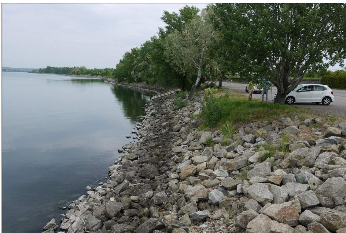
Zájmový úsek břehu – uložení patky lávky do opevněné části břehu, dalby pro kotvení mola budou kotveny do dna pod vodní hladinou
