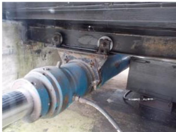
Závěsné zařízení stávajícího pohonu
