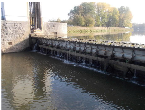
Pohled na stávající konstrukci zdvižného stavidla jezu Hradištko
