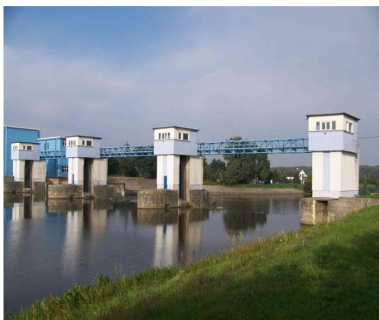
Pohled na stávající konstrukci zdvižného stavidla jezu Hradištko
