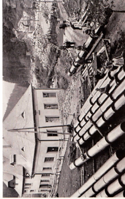
Přirubové nýtované tlakové potrubí připravené k montáži. Vlevo elektrárna Rudolfova I, vpravo prostor budoucí vyrovnávací nádrže, zcela vpravo část kamenolomu otevřeného pro potřeby stavby, 1926
