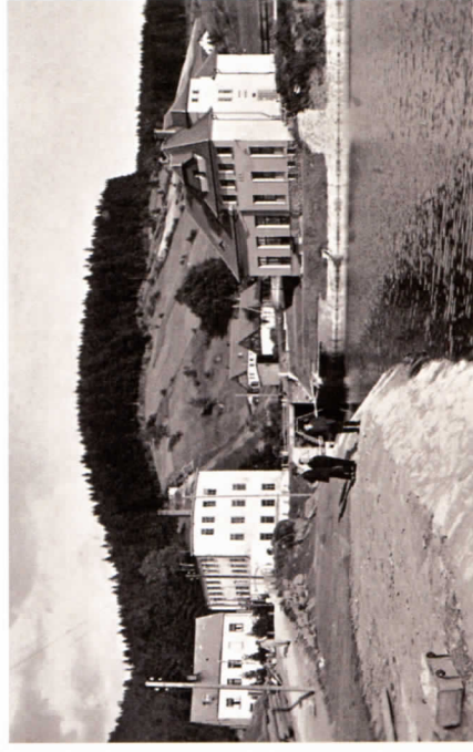
Elektrárna po napuštění vyrovnávací nádrže. Vlevo od mostu továrna Alexandra Spitzze. Na svahu je patrná trasa tlakového potrubí, asi 1928
