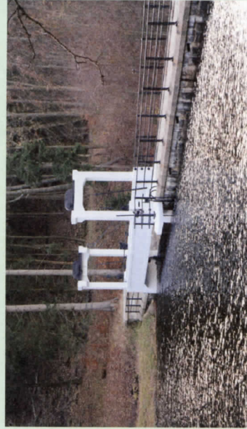
Hráz vyrovnávací nádrže s automatickým klapkovým uzavěrem
