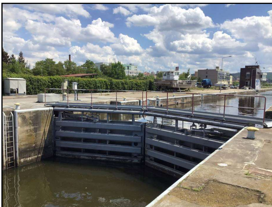
Dolní vzpěrná vrata plavební komory Modřany.
