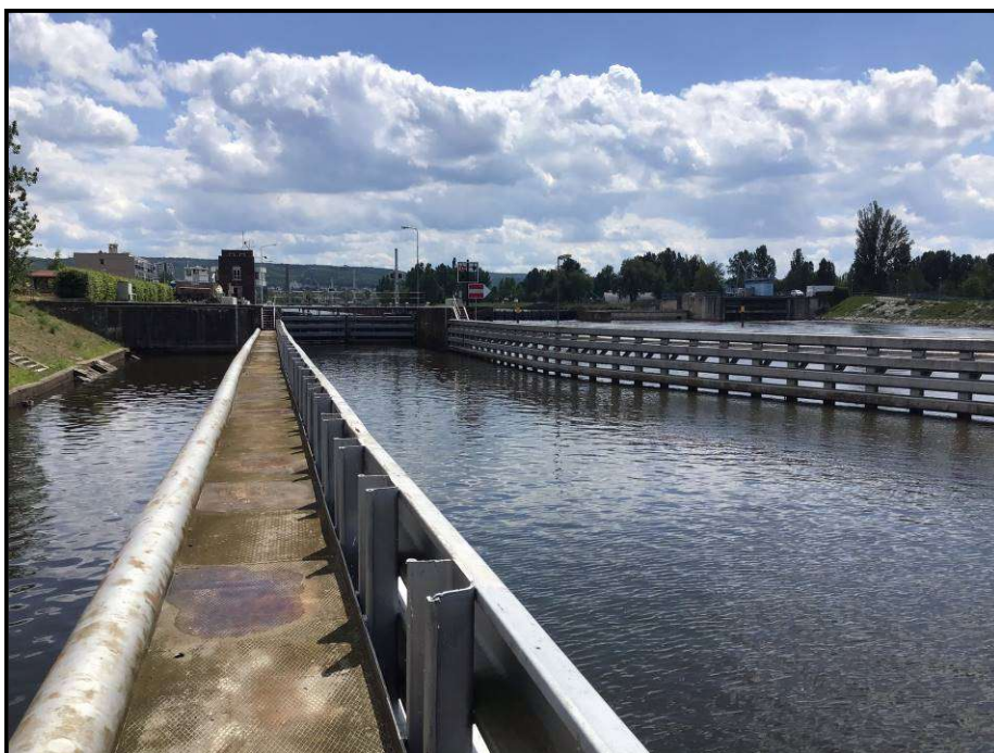
Dolní rejda pod plavební komorou s pružnými svodidly.
