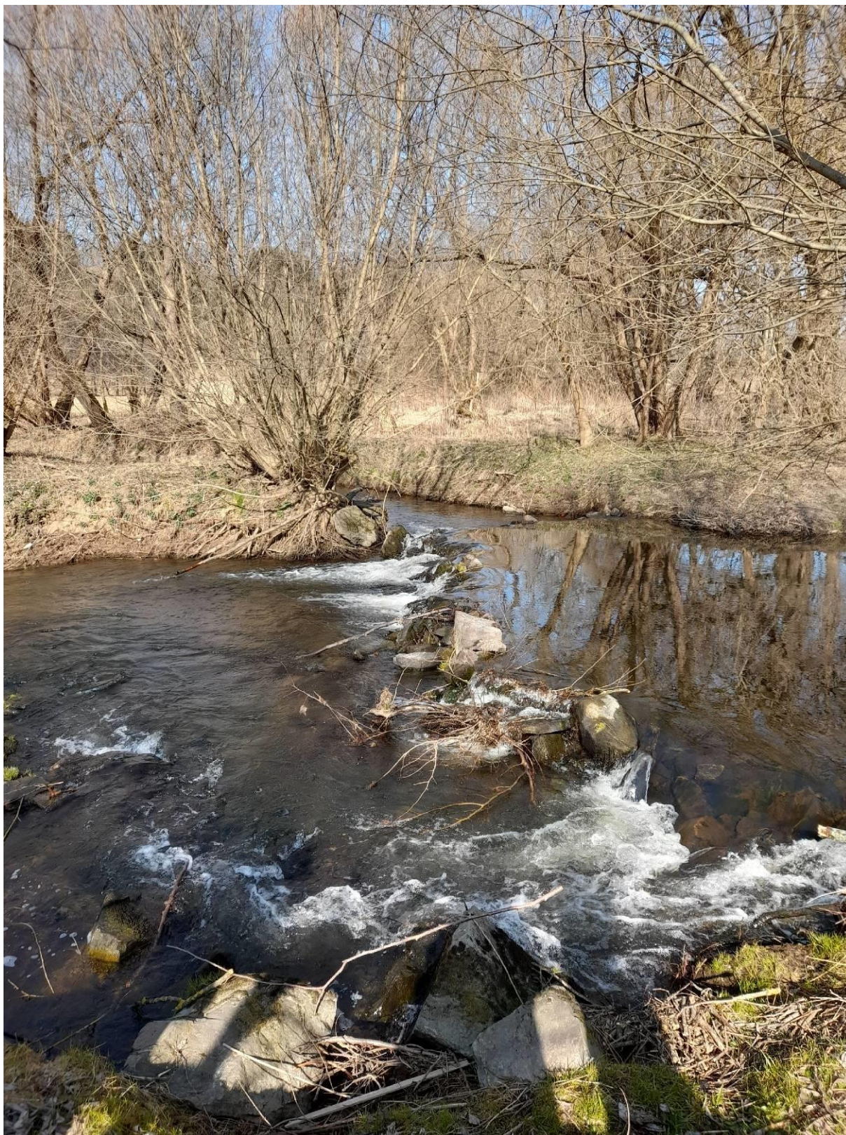
Obr. 15: Odstranění stávající drobné migrační překážky u nižších průtoků (kameny vkládány do obnovovaného koryta).
