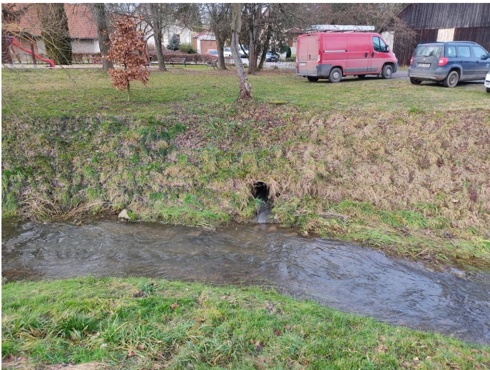
Stávající vyústění z kanalizace. Potrubí DN 500.
