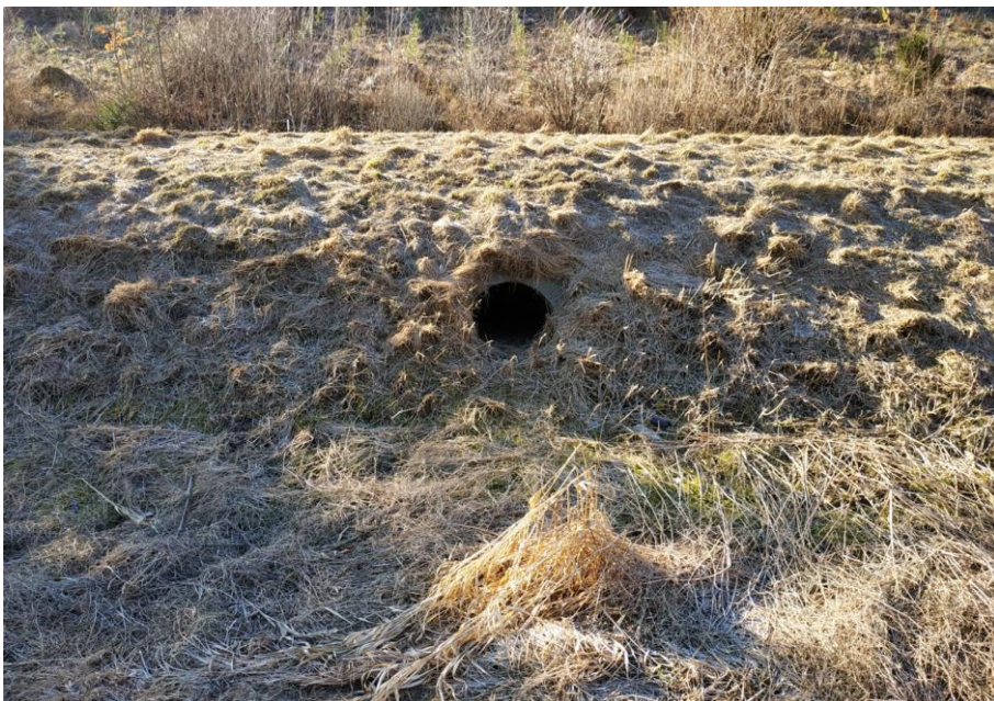
Propustek v tělese komunikace
