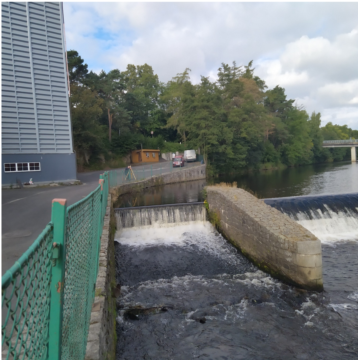
Pohled na štěrkovou propust a pravý břeh stávajícího jezu Mrskoš.
