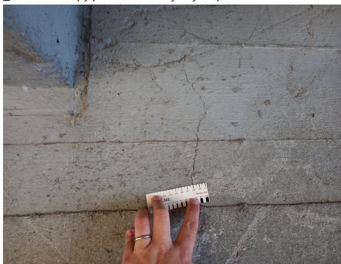
_094409 - svislá trhlina na pilíři P2, šíře až 0,8mm
