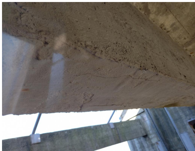
_101839 - drobná trhlinka na podledu levého trámu pole 2
