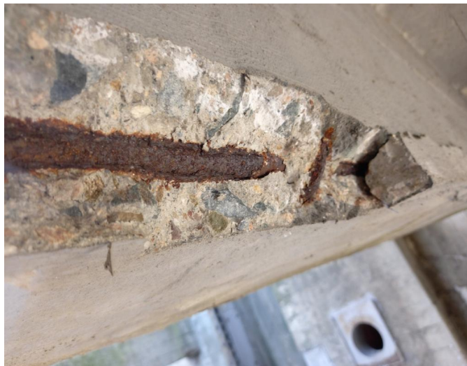
_104634 - lokálně obnažená nosná výztuž 3. pole, levý trám
