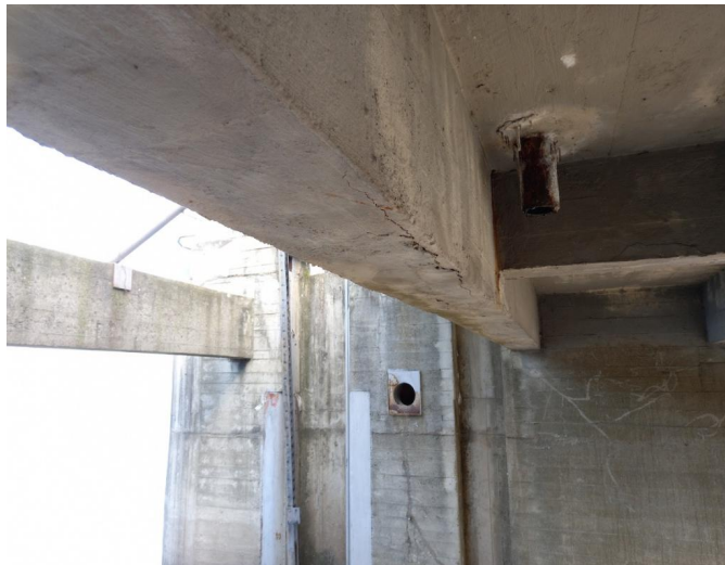
_094713 - trhлина na pdhledu levého trámu pole 3
