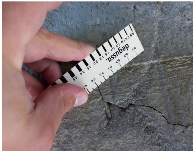
_105232 - místy na opěře O10 svislé i horizontální trhliny, šíře do 0,6mm
