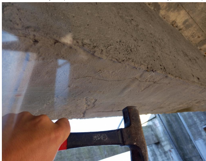
_101834 - drobná trhlina na podledu levého trámu pole 2
