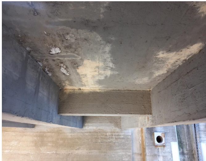
_102357 - stav zatékání, pole 2
