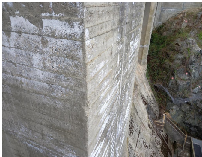
_155212 - stav zatékání na pilíři P3
