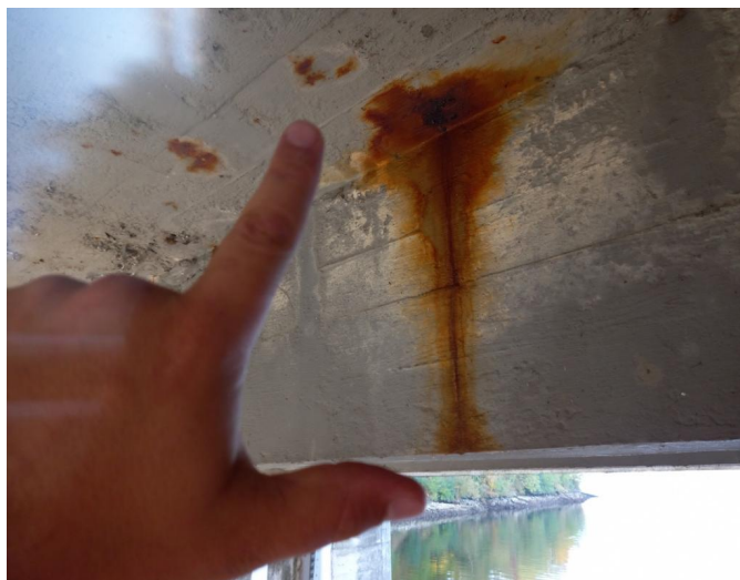
_095700 - pole 1, 2. trám zleva - korozivní výtok
