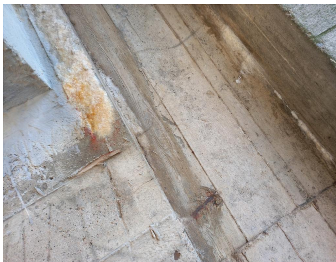
_094233 - stav zatékání, pole 1
