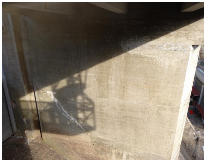
_095222 - trhlina s výluhem na ploše pilíře P2
