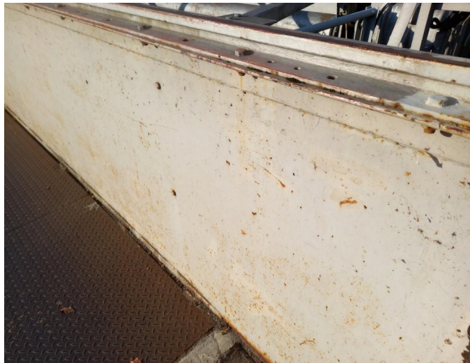
_091429 - místy drobně prorýsovaná koroze příslušenství mostu
