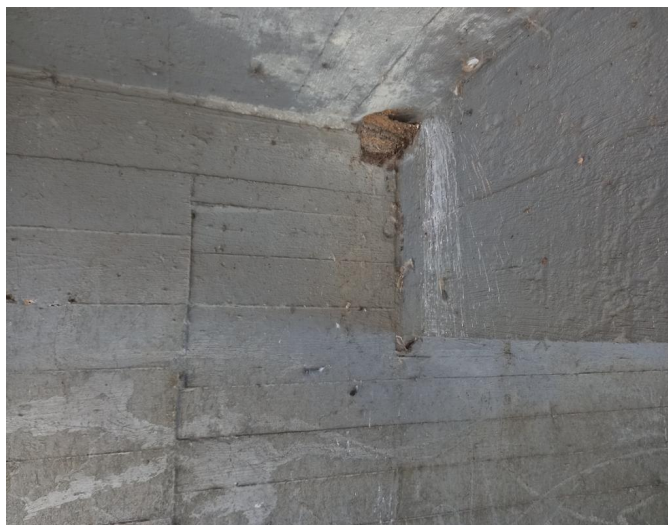
_094540 - stopy po zatékání a výluhy na podledu na začátku pole 3
