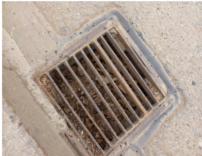
_144539 - vpustě jsou zanešené nečistotami
