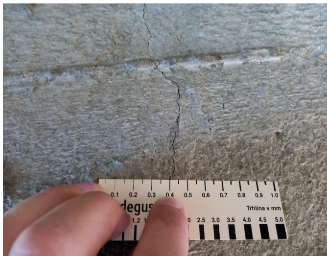
_100208 - místy na pilíři P2 svislé i horizontální trhliny, šíře do 0,2mm
