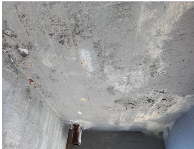
_094721 - stopy po zatékání a výluhy na podledu pole 3, zejména v okolí odvodňovače na konci pole
