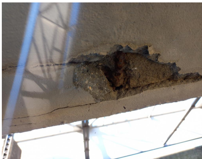
_104033 - lokálně obanžená výztuž nosné konstrukce pole 3
