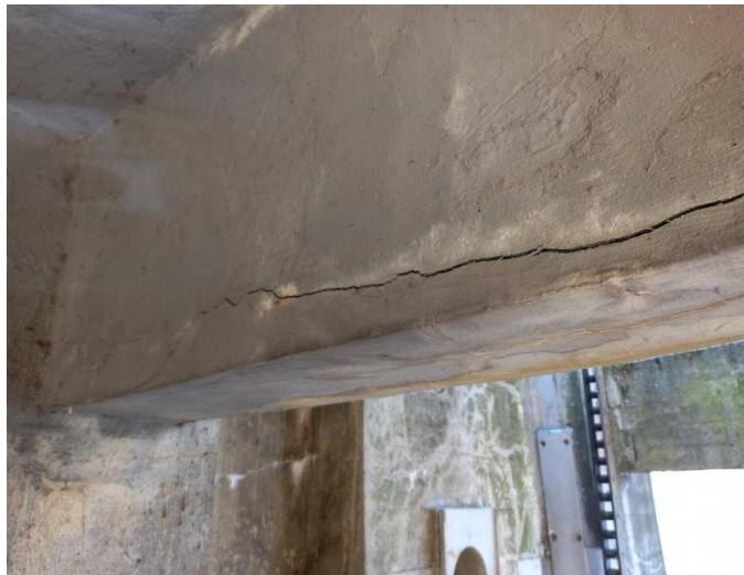
_103840 - horizontální trhlina podhledu levého támu pole 3, dutý povrch
