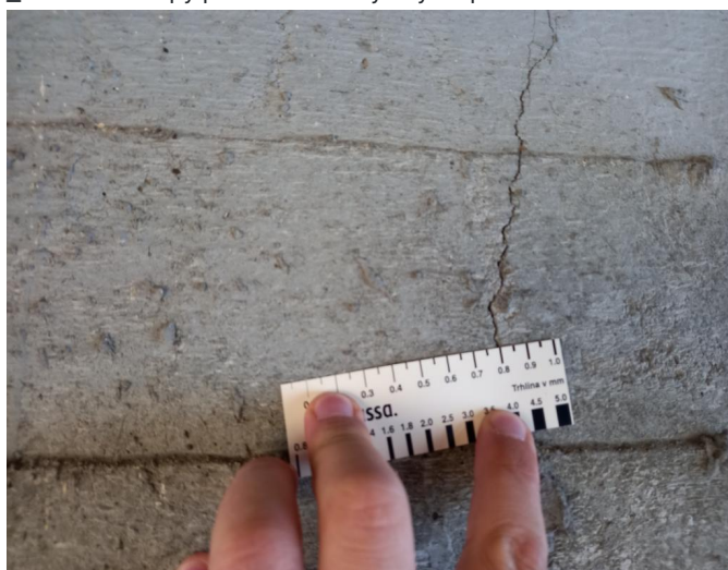
_094411 - svislá trhlina na pilíři P2, šíře až 0,8mm
