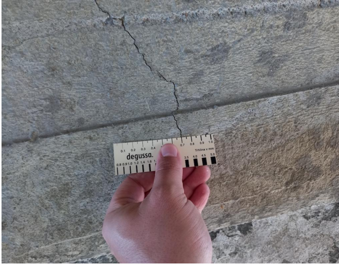
_105334 - místy na opěře O10 svislé i horizontální trhliny, šíře do 0,6mm
