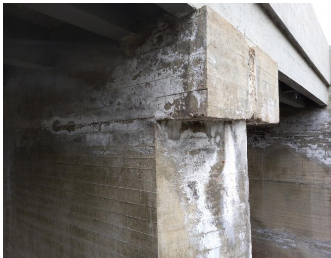
_154637 - stav zatékání na pilíři P3
