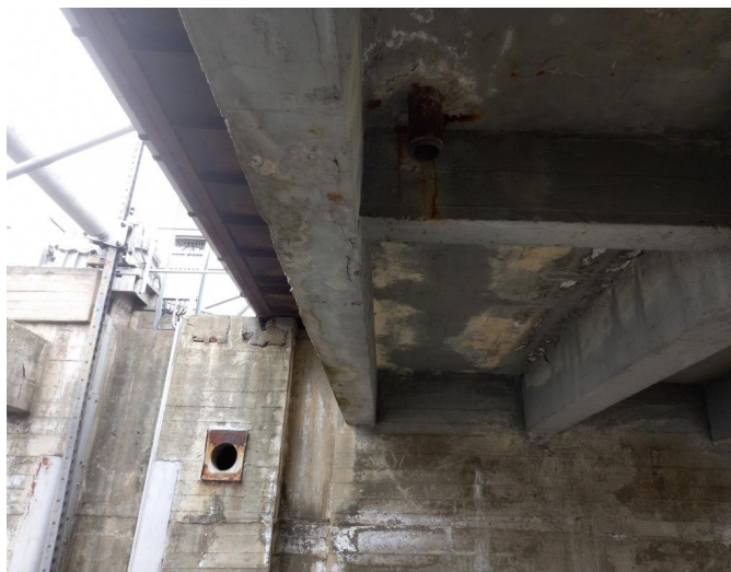
_154457 - stav zatékání do podhledu pole 2
