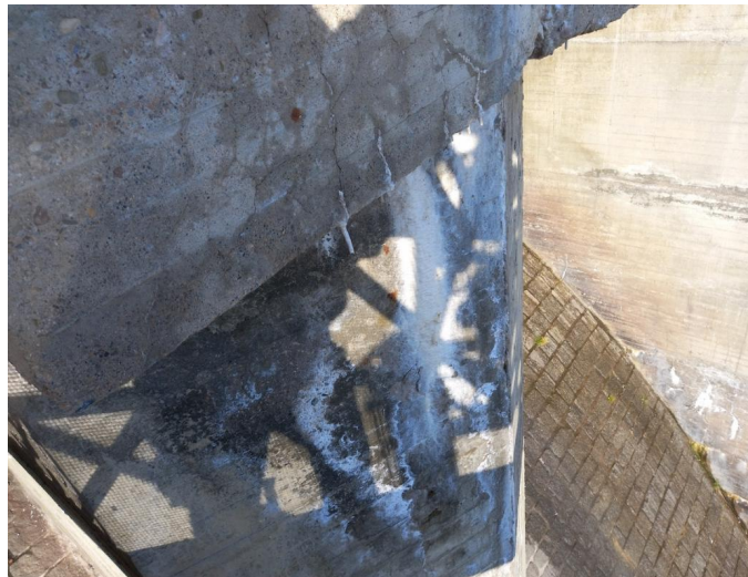
_102145 - lokálně výluhy na povrchu pilíře P2
