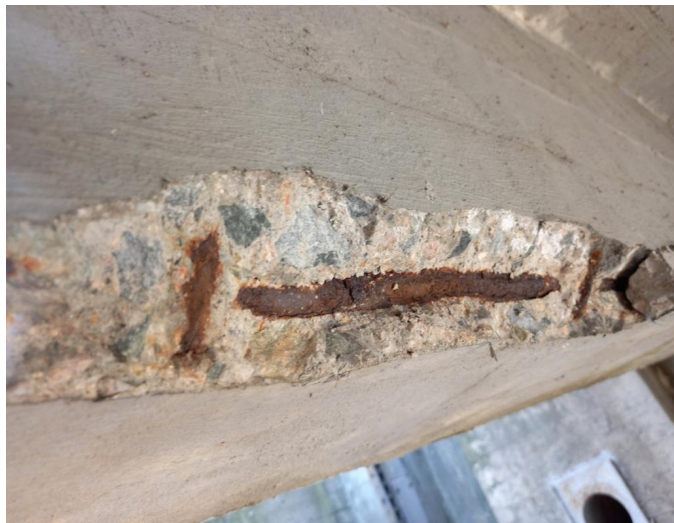
_104627 - lokálně obnažená nosná výztuž 3. pole, levý trám
