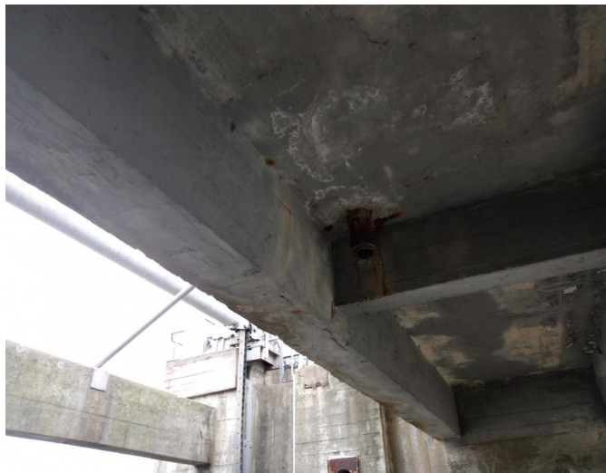
_154429 - stav zatékání do podhledu pole 2
