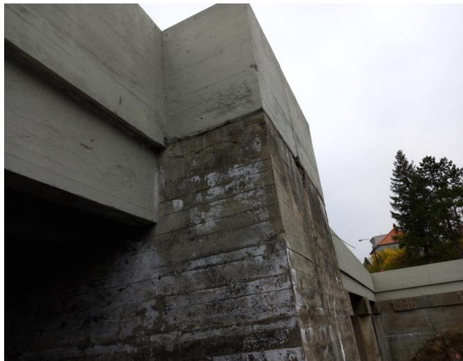
_155205 - stav zatékání na pilíři P3
