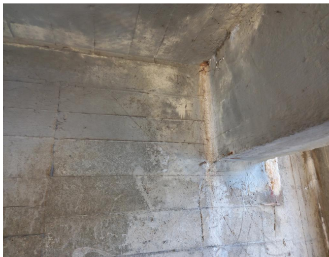
_094308 - stopy po zatékání a výluhy v levém rohu podleu na začátku pole 1
