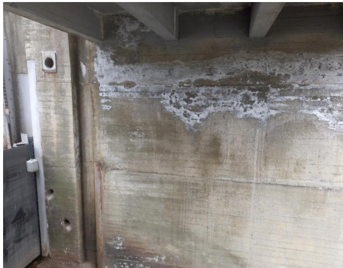
_154936 - stav zatékání na opěře O4
