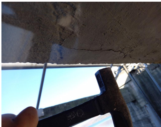
_101848 - drobná trhlinka na podledu levého trámu pole 2
