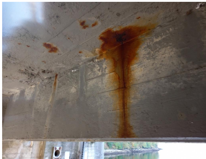
_095705 - stopy po zatékání a výluhy na podledu pole 3, zejména v okolí odvodňovače na konci pole
