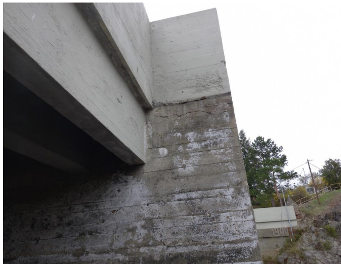
_155154 - stav zatékání na pilíři P3
