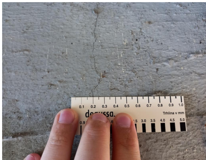
_100129 - místy na pilíři P2 svislé i horizontální trhliny, šíře do 0,2mm
