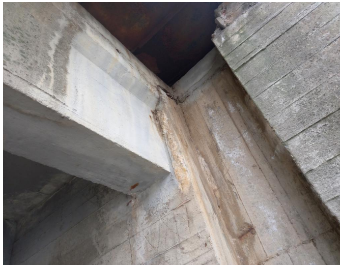
_153705 - stav zatékání na NK pole 1
