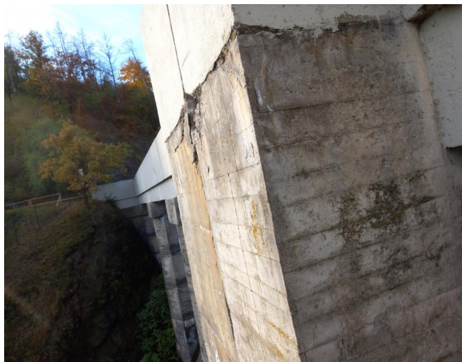
_095347 - lokálně degradovaný povrch mezi dobetonávkou a pilířem P2
