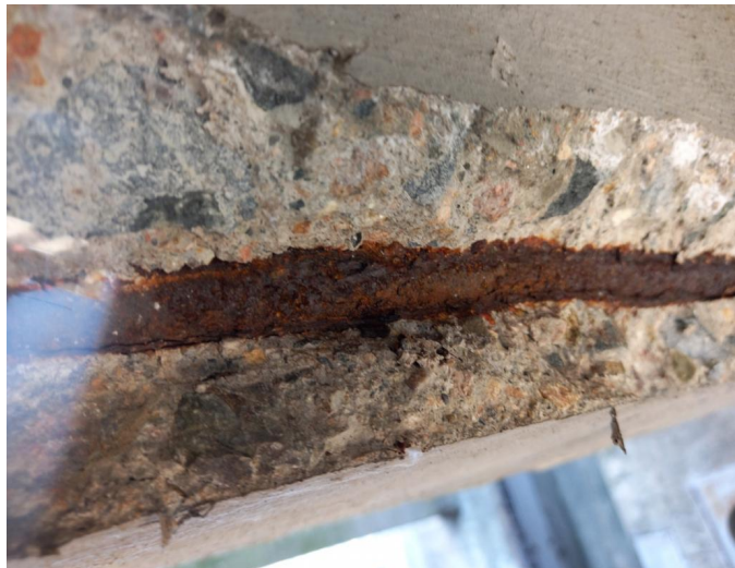
_104647 - lokálně obnažená nosná výztuž 3. pole, levý trám
