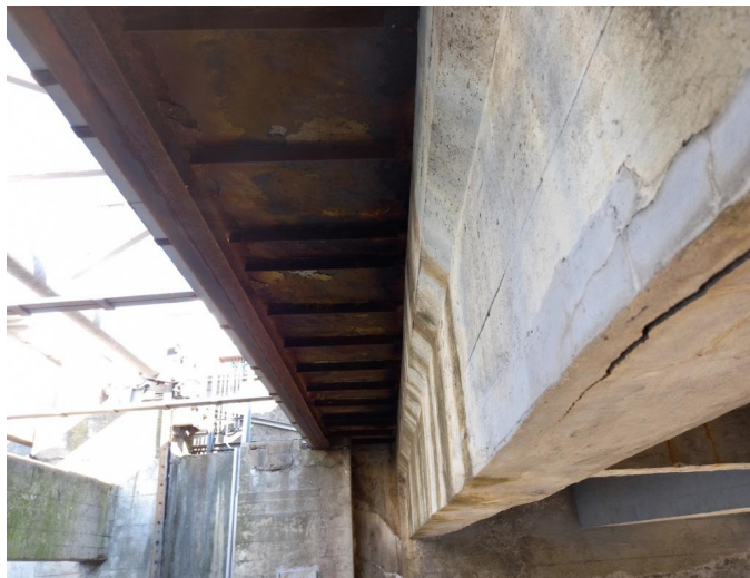
_103958 - horizontální trhlina podhledu pravého támu pole 3, dutý povrch
