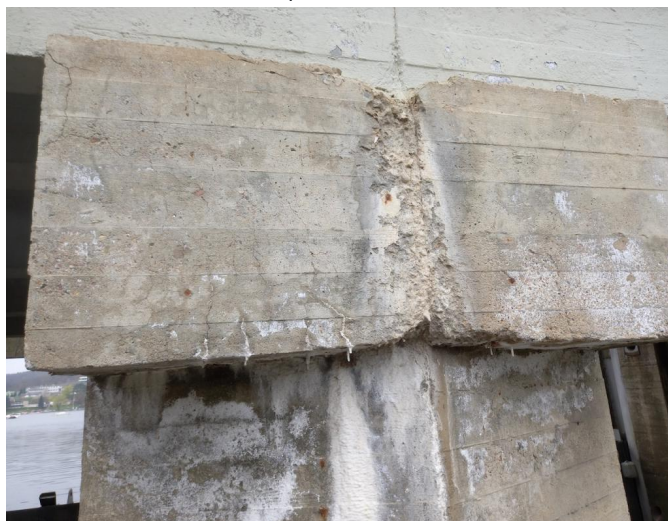
_154708 - stav zatékání na pilíři P3
