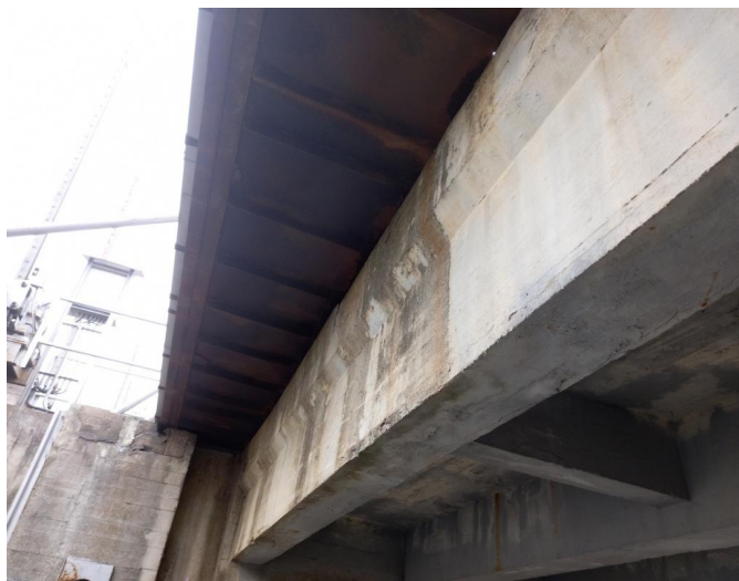
_153700 - stav zatékání na NK pole 1
