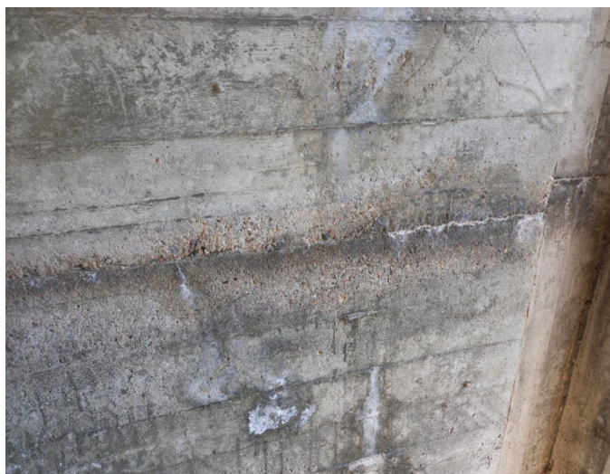
_094331 - stopy po zatékání a výluhy na pilíři P2
