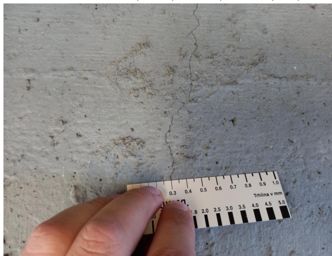
_101351 - místy na pilíři P2 svislé i horizontální trhliny, šíře do 0,3mm
