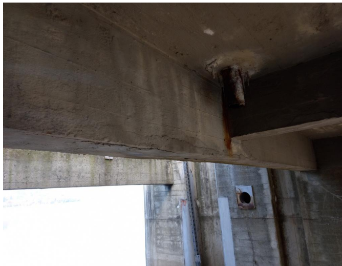
_094731 - stopy po zatékání a výluhy na podledu pole 3, zejména v okolí odvodňovače na konci pole
