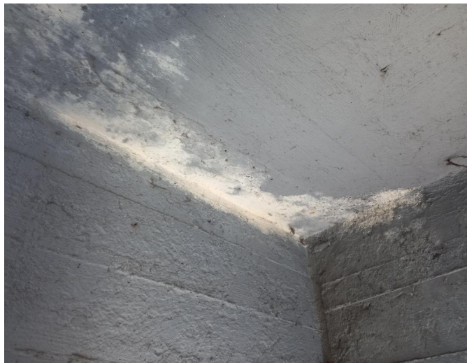
_102404 - stav zatékání, pole 2
