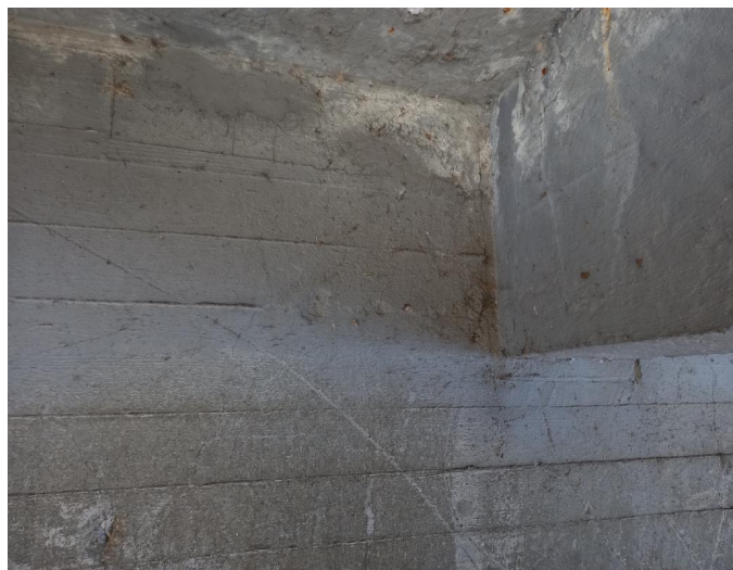
_094515 - stopy po zatékání a výluhy na podledu na začátku pole 3
