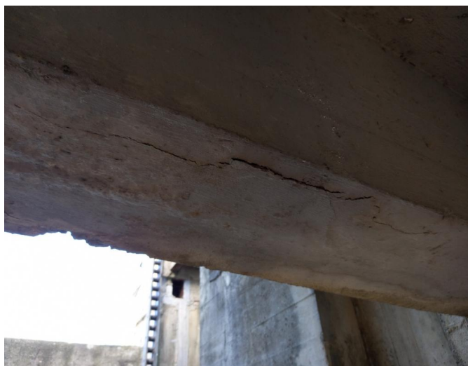
_095911 - trhlina na podhledu levého trámu pole 1
