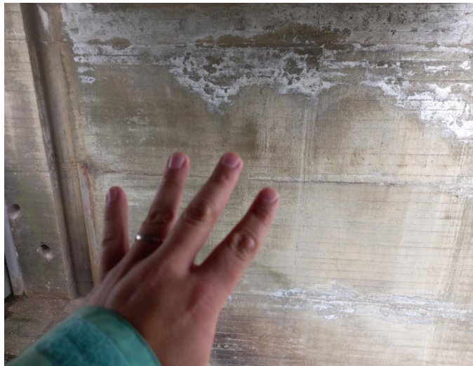
_154927 - stav zatékání na opěře O4
