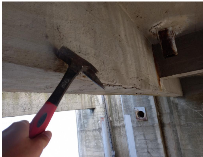
_094800 - stopy po zatékání a výluhy na podledu pole 3, zejména v okolí odvodňovače na konci pole
