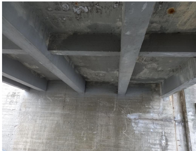
_153950 - stav zatékání na NK pole 1
