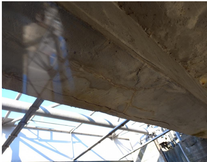
_103920 - horizontální trhlina podhledu levého támu pole 3, dutý povrch
