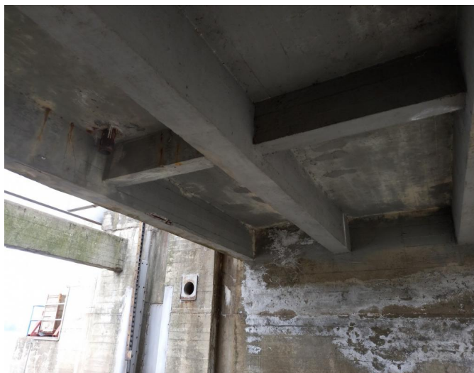
_154923 - stav zatékání do podhledu pole 3"
