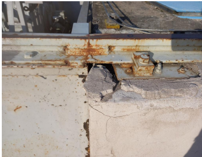
_091724 - místy drobně prorýsovaná koroze příslušenství mostu
