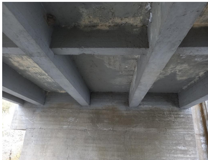
_154520 - stav zatékání do podhledu pole 2
