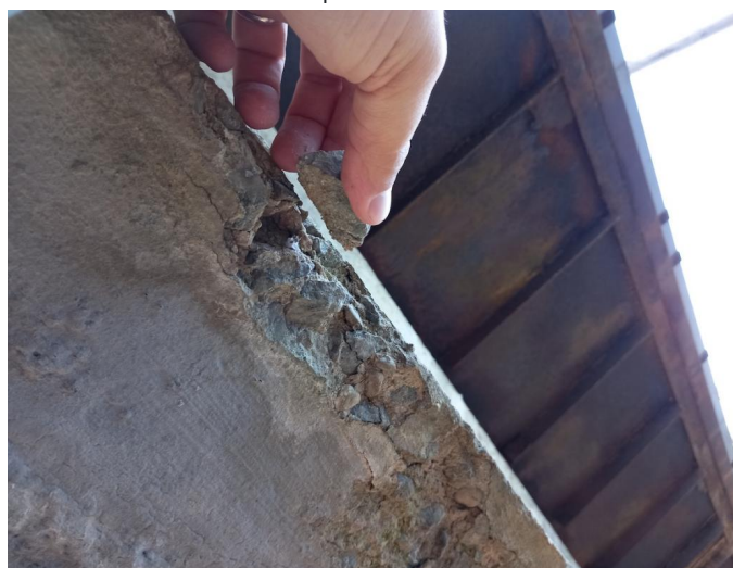
_095933 - trhlina na podhledu levého trámu pole 1
