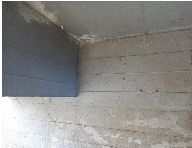
_094550 - stopy po zatékání a výluhy na podledu na konci pole 3
