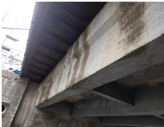
_154438 - stav zatékání na NK pole 2
