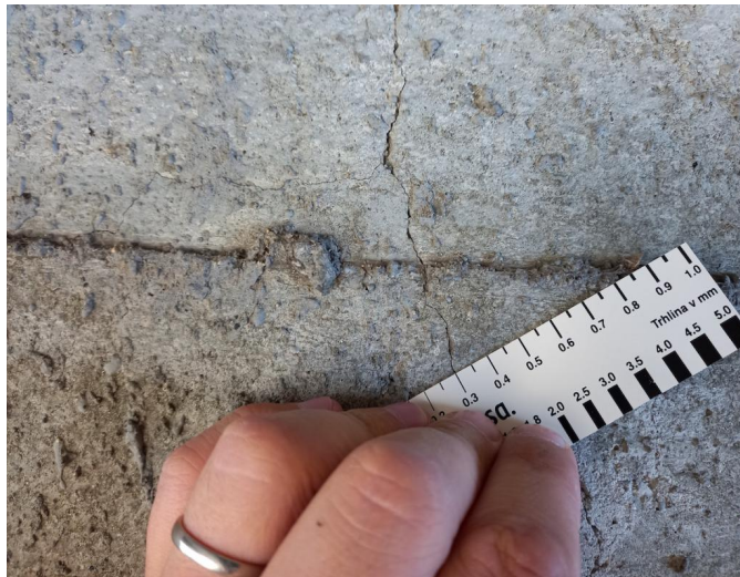
_101300 - místy na pilíři P2 svislé i horizontální trhliny, šíře do 0,2mm
