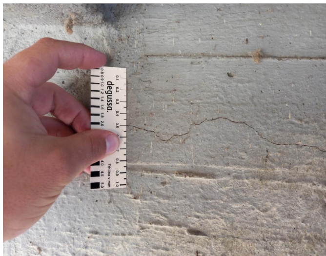
_103730 - místy na pilíři P3 svislé i horizontální trhliny, šíře do 0,5mm
