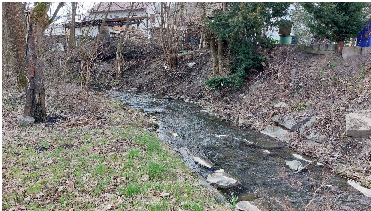
Foto č.6: Pohled na stávající stav VT po toku od KÚ; viditelná dobíhající kamenná rovinanina od výše provedeného úseku úpravy toku.
