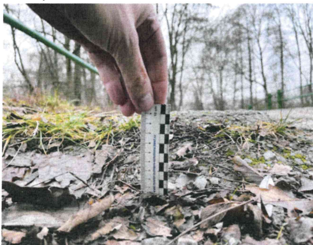
IMG_5353 - prosedlá vozovka v přechodu na most na konci mostu až o cca 100mm
