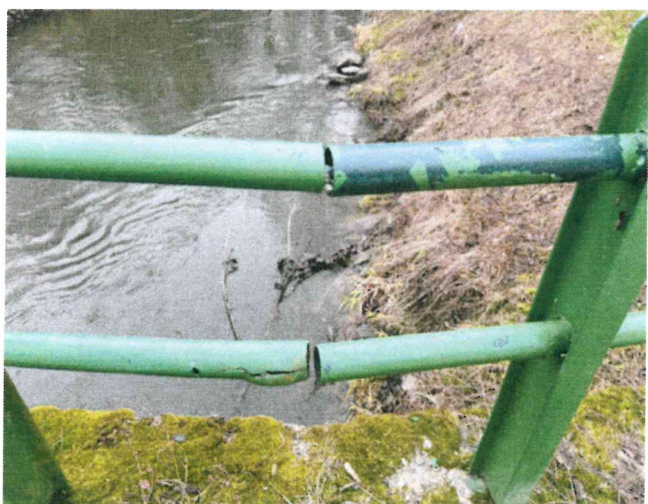
IMG_5348 - prasklý profil spodní výplně zábradlí na konci mostu vlevo
