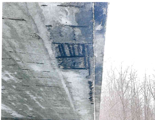
IMG_5375 - na podhledu NK se lokálně vyskytují stopy po zatékání, obnažené třmínky i nosná výztuž, n
