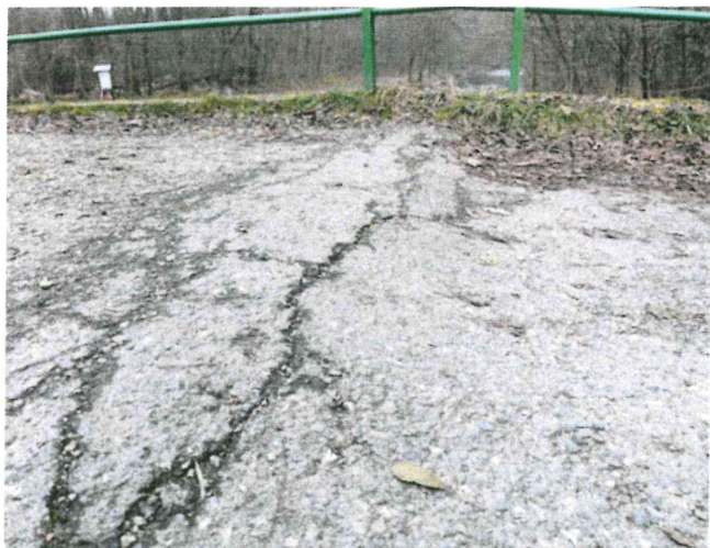
IMG_5328 - otevřené příčné trhliny ve vozovce v přechodu na začátku mostu
