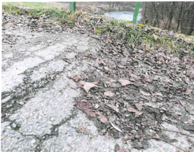
IMG_5330 - prosedlá vozovka v přechodu na most na začátku mostu až o cca 80mm
