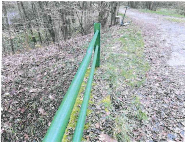
IMG_5358 - mírná deformace pravého zábradlí
