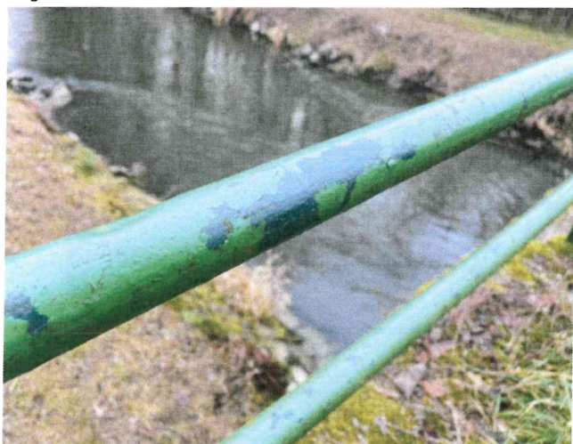
IMG_5344 - PKO zábradlí je dožilá, prozatím bez větší koroze
