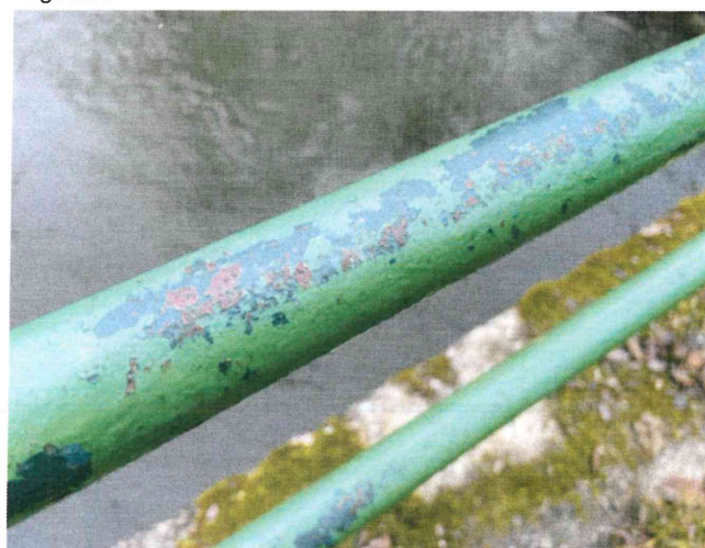
IMG_5345 - PKO zábradlí je dožilá, prozatím bez větší koroze
