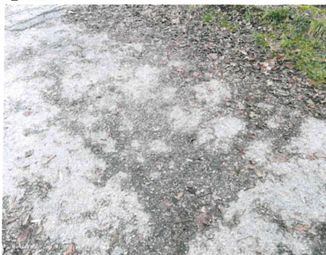
IMG_5326 - otevřený povrch živíčního krytu na předpolí na začátku mostu
