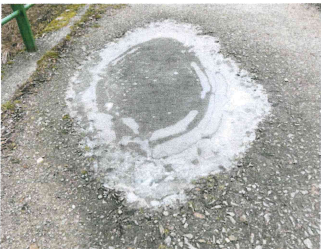
IMG_5332 - prosedlá vozovka na nosné konstrukci, ve 2:3 délky mostu vlevo
