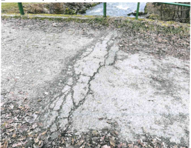
b_Přechod vozovky na most na začátku mostu
