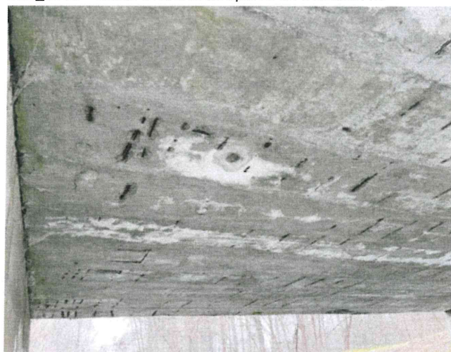
IMG_5372 - na podhledu NK se lokálně vyskytují stopy po zatékání, obnažené třmínky i nosná výztuž, n
