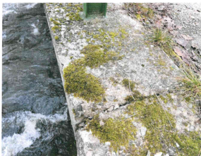
IMG_5354 - na římsách jsou neutěsněné příčné pracovní spáry
