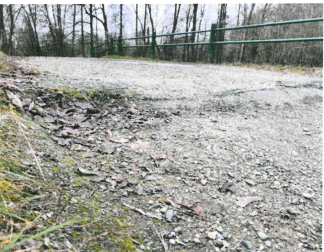
IMG_5335 - prosedlá vozovka v přechodu na most na konci mostu až o cca 100mm
