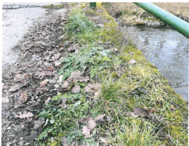
IMG_5350 - římsy jsou místy porostlé mechem a jsou na nich uchycené nečistoty
