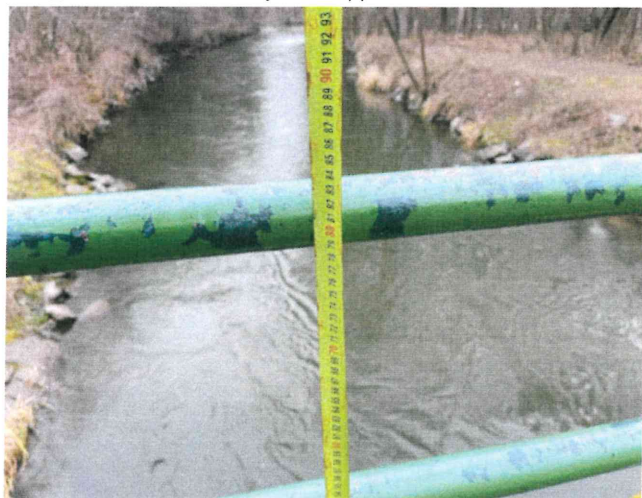
IMG_5346 - výška zábradlí je 820mm, nesplňuje současné normové požadavky
