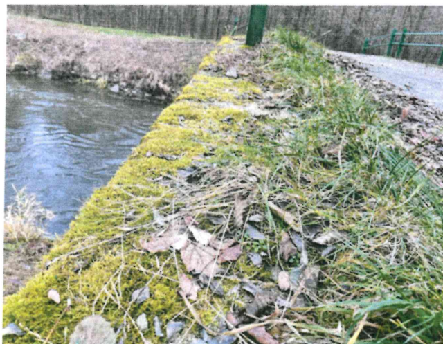
IMG_5343 - podél říms jsou usazené nečistoty a v nich je uchycená vegetace
