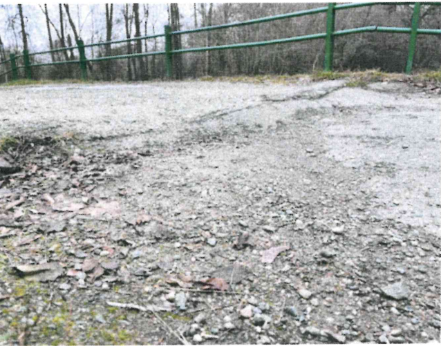
IMG_5336 - prosedlá vozovka v přechodu na most na konci mostu až o cca 100mm
