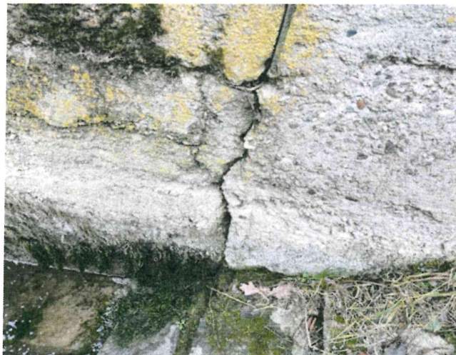
IMG_5363 - svislá trhlina mezi opěrou O1 a křídlem K1
