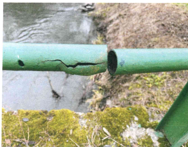
IMG_5347 - prasklý profil spodní výplně zábradlí na konci mostu vlevo
