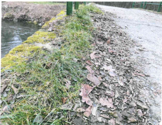
IMG_5342 - podél říms jsou usazené nečistoty a v nich je uchycená vegetace
