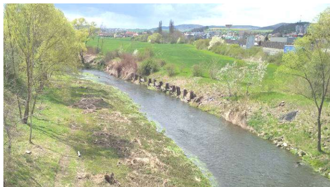
levobřežní degradované technické opevnění
