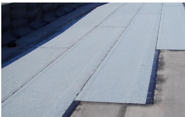
Obr. 3: montáž asfaltových pásů s vystřídanými spoji
