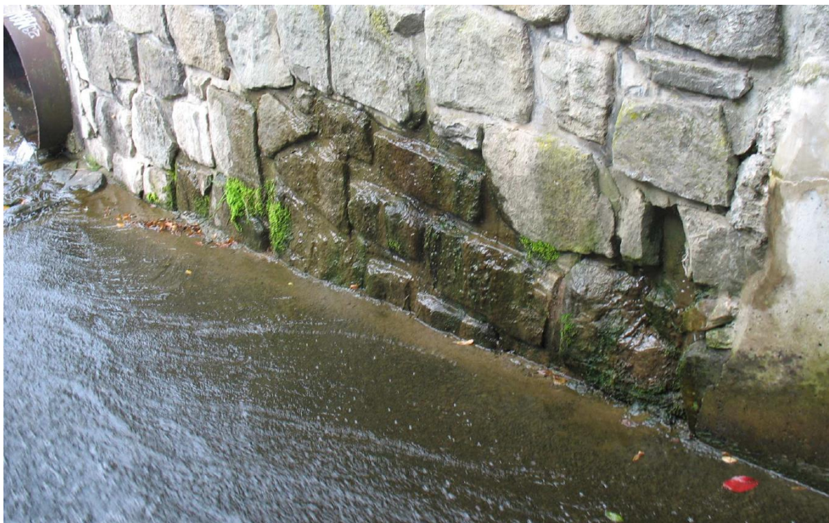
detail průsaku na PB
