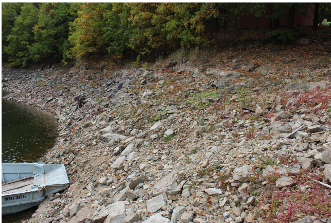
Obr. 2 Pohled na svah břehu, kde budou realizovány opěrné trámce. Na fotografii je patrný kamenitý terén s vystupující kompaktní skálou, dále je vidět rozmezí břehu bez porostu a stromů nad zásobní hladinou nádrže. Taktéž je vidět současné nevyhovující stání plavidla přídí přímo o kamenitý břeh.
