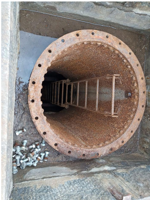
Foto č. 5 – Žebřík do obtoků (E), výměna za nerezový
