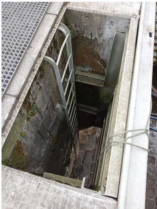
Foto č. 5 – Žebřík do dolní vody (F), výměna za nerezový
