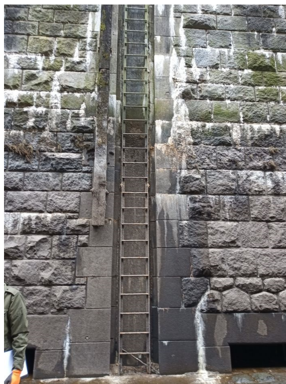
Foto č. 3 – Dlouhý žebřík (B) o délce 24,5 m, výměna spodního dílu
