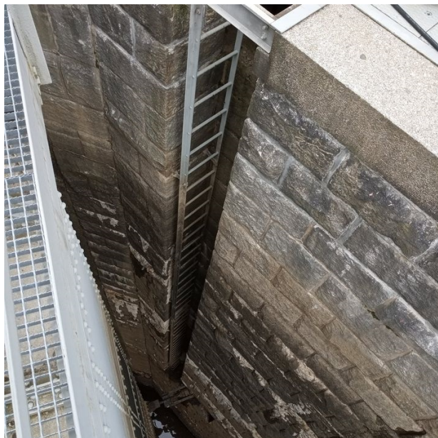
Foto č. 4 – Žebřík ve vrátnovém výklenku (D), výměna dolního dílu
