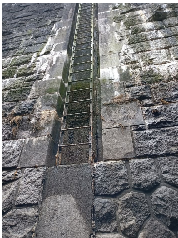
Foto č. 2 – Krátký žebřík (A, C) o délce 21,5 m, výměna spodního dílu
