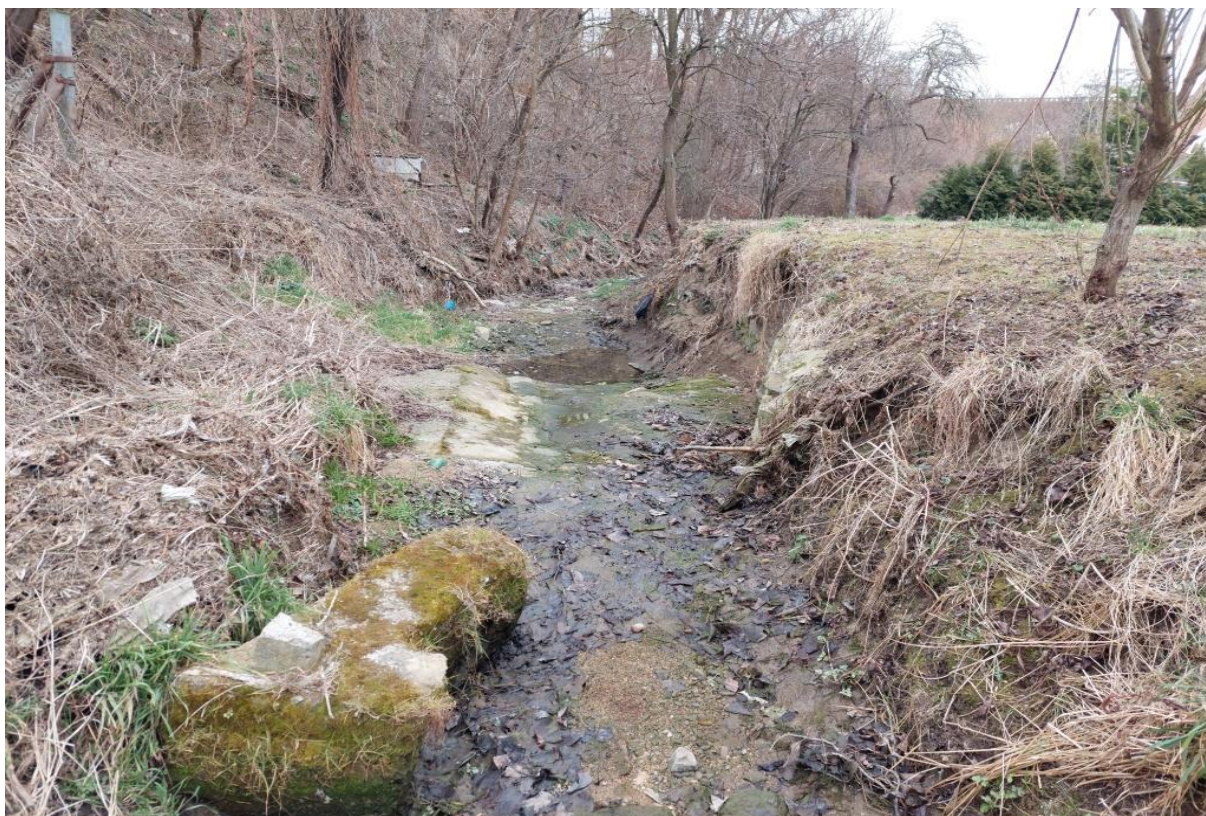
9. Příčný profil 12, pohled z koryta po proudu, betonový zákryt křížení optického zemního vedení (Optokon, Nej.cz), ř. km 2,5800
