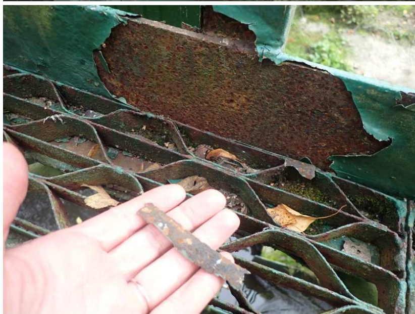
Navazující ocel. prvky na NK silně poškozené korozí
