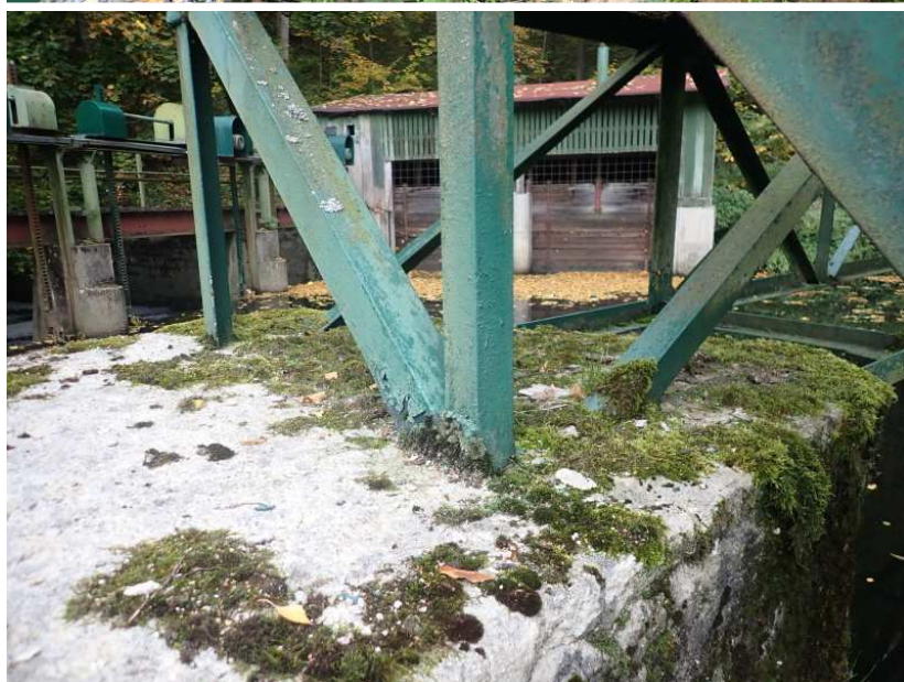
Vetknutí NK lávky do levobřežní opěry
