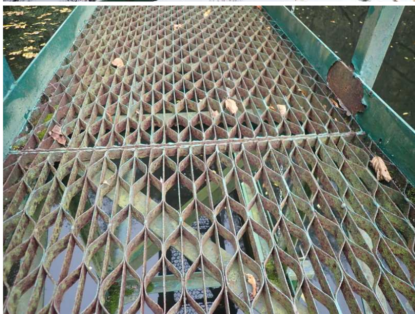
Ocel. rošty pochozí mostovky a navazující ocel. prvky silně poškozené korozi
