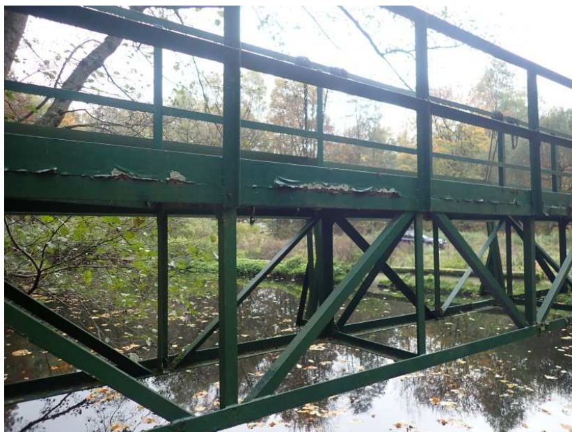
Poškozená PKO NK a navazujících ocel. prvků lávky
