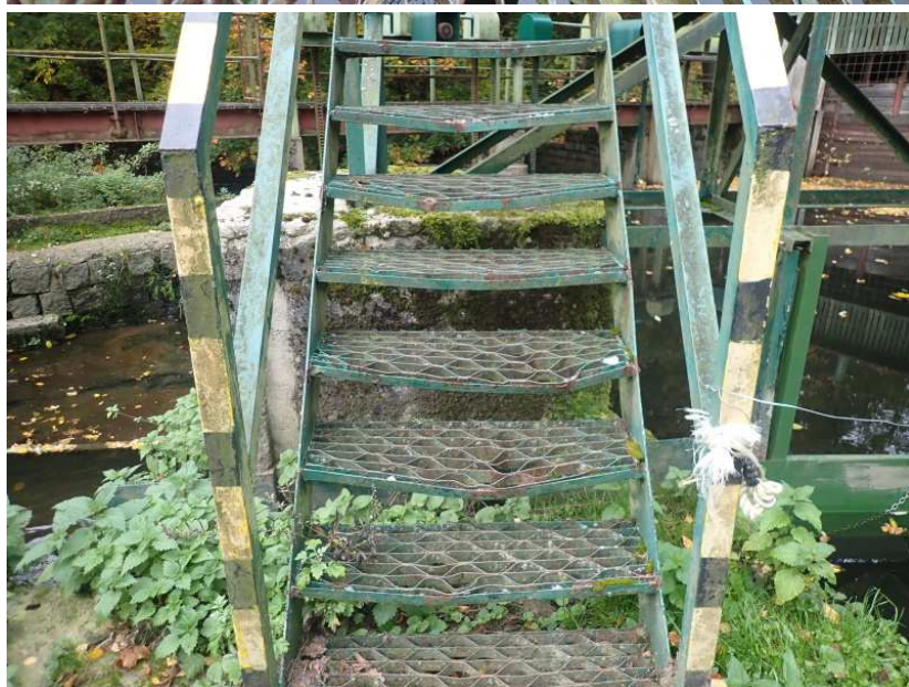
Poškozené ocel. schodiště u levobřežní opěry
