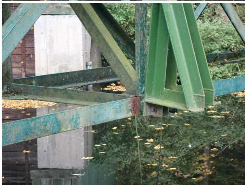
Koroze dolní pásnice v místě styčnicku
