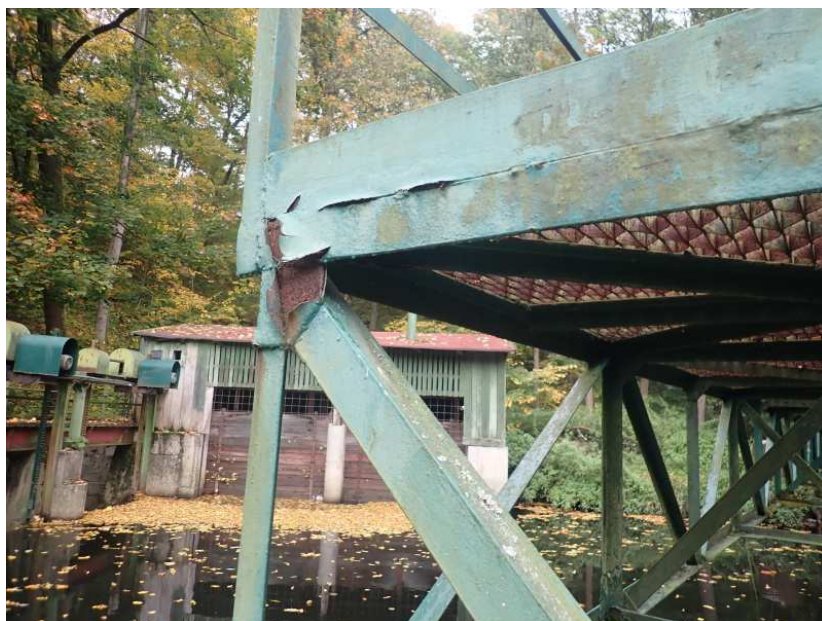
Detail koroze NK na výtoku vlevo
