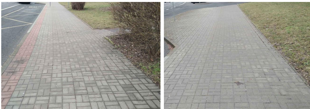
Obrázek 3: Propadlá dlažba a obrubník, nerovnosti v dlažbě.
