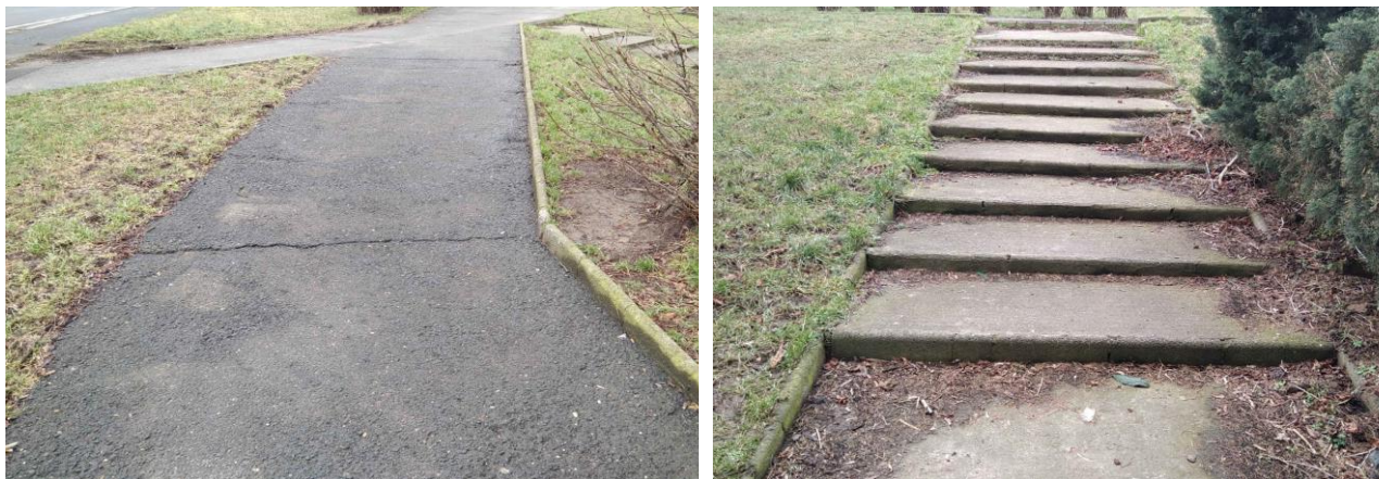
Obrázek 2: Poškození chodníků, betonové schodiště u panelového domu.
