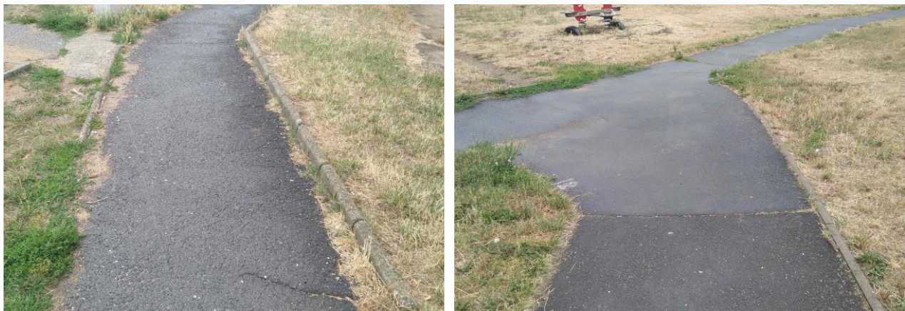
Obrázek 6: Asfaltové chodníky v okolí ulice Rovná – místy praskliny a souvisle poškozený povrch.
