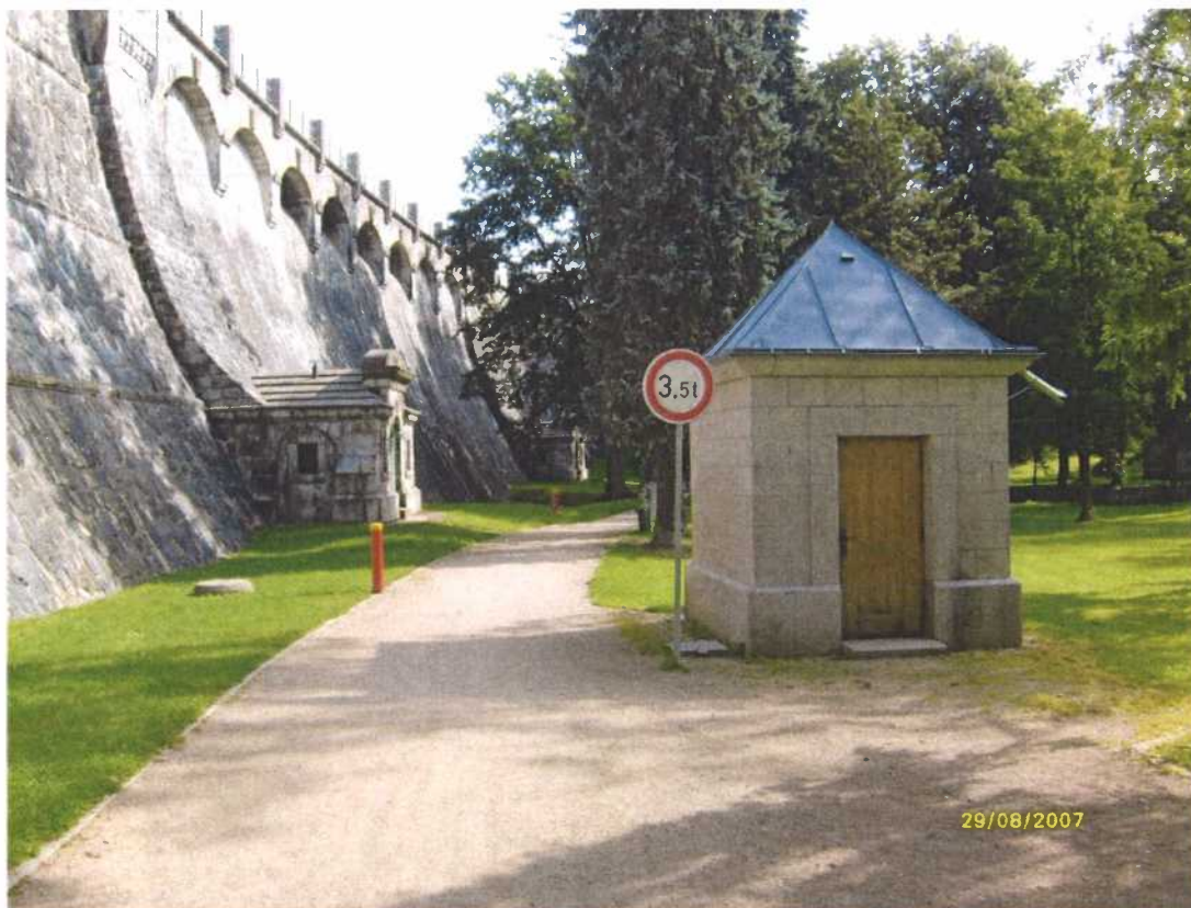
VD Mšeno injekční štola
