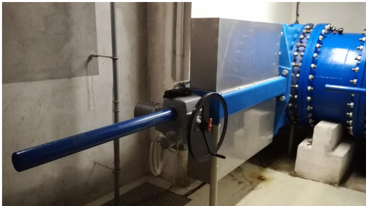
Foto stávajícího uzávěru ve strojovně
