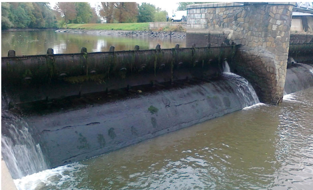
Obr.: Jez Rajhrad – nevyhovující stav betonů přelivů a klapek (boční průsaky).
