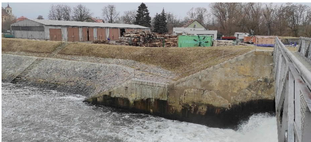
Obr.: Jez Rajhrad – nevyhovující stav betonů krajních pilířů v podjezí (leden 2022).
