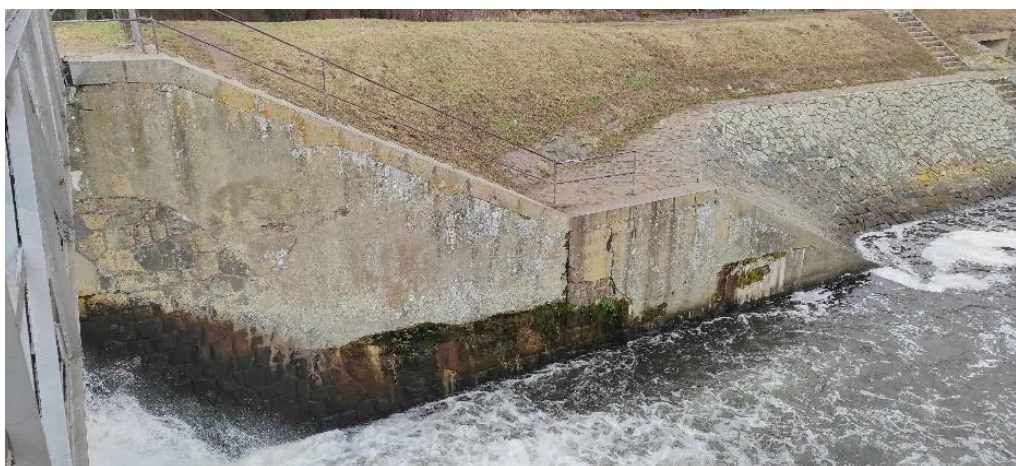
Obr.: Jez Rajhrad – nevyhovující stav betonů krajních pilířů v podjezí (leden 2022).
