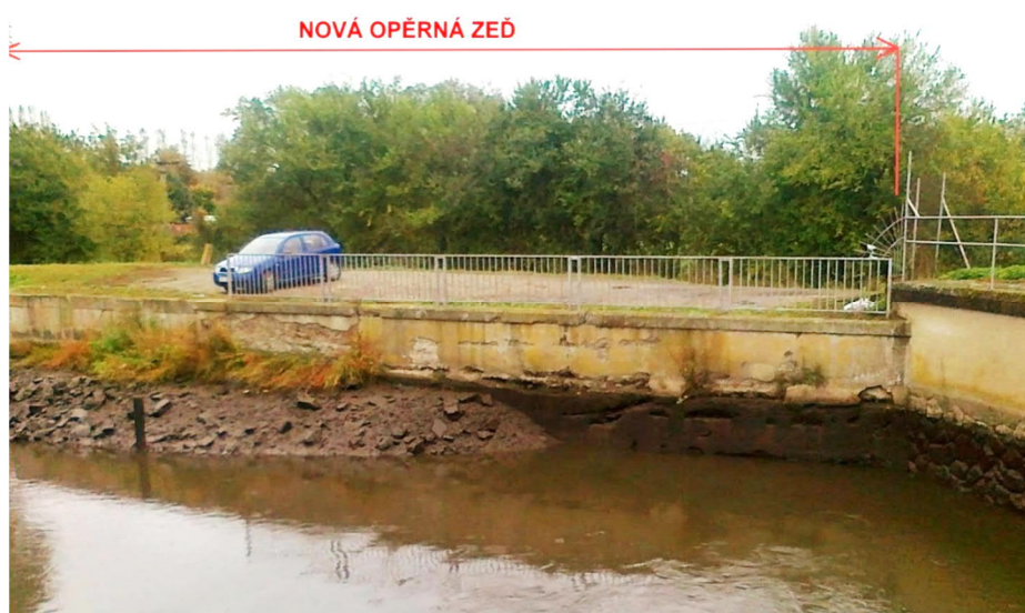
Obr.: Jez Rajhrad – nevyhovující stav betonů levobřežní zďa jezu v roce 2016 a strojovny.
