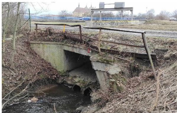
Obr.: Vyústění a ŽB mostek přes Ivanovický potok na levém břehu pod jezem Rajhrad.
