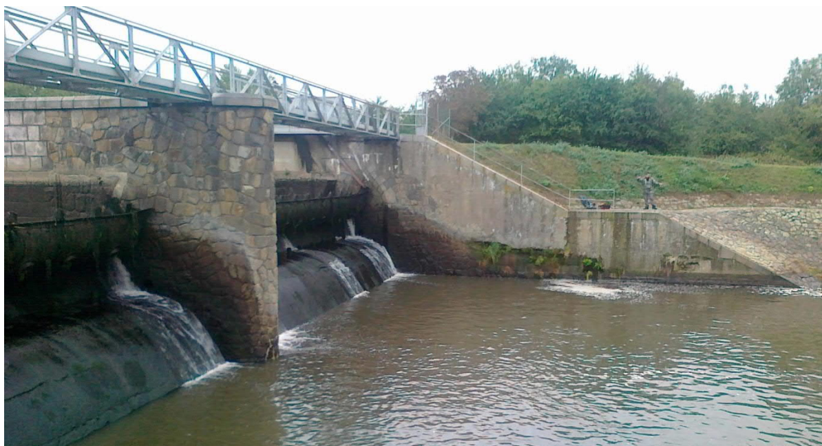
Obr.: V rámci rekonstrukce se provede přespárování (příp. zainjektování) trhlín a kaveren na spodním pilíři a pro zamezení bočních průsaků bude navržena podzemní těsnicí stěna ze sloupů injektáže.
