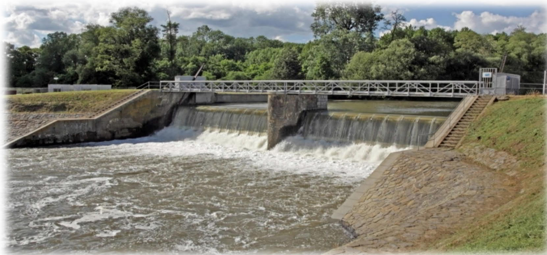
Obr.: Jez Rajhrad je pro jeho spád 5,2 m ideálním profilem pro hydroenergetické využití Svratky.
