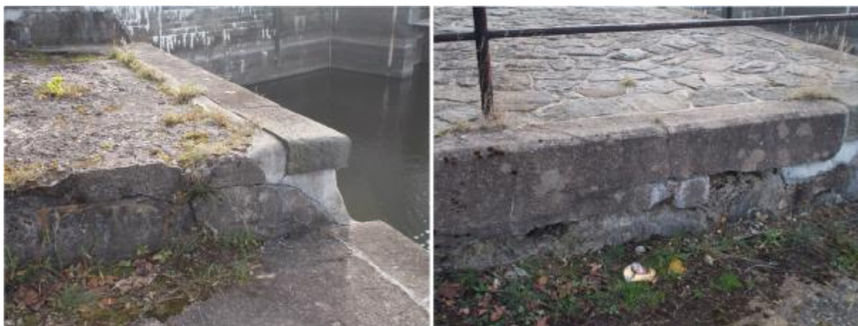
Narušené římsy a stupně koruny
