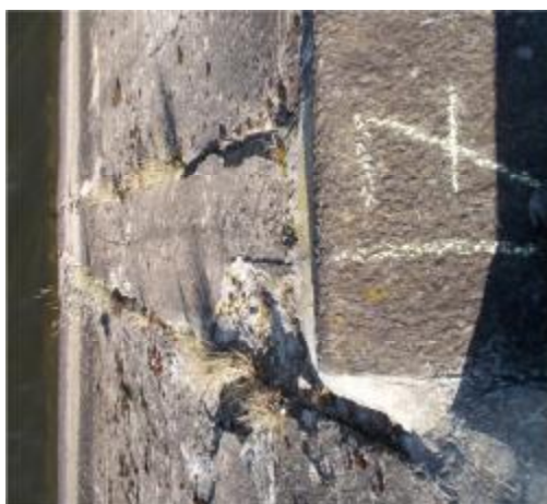
Narušení svislých pracovních spár v líci
