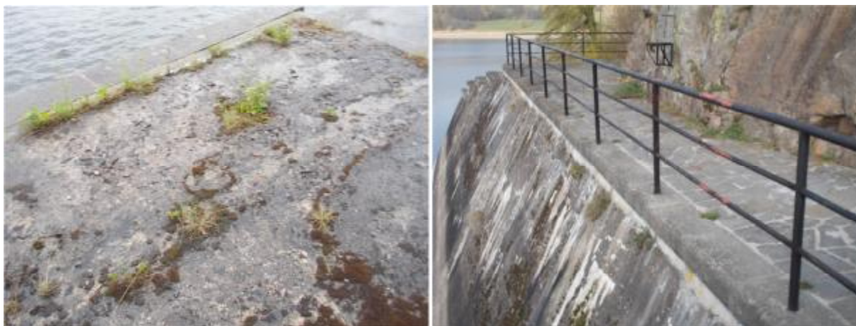
Narušený povrch a zábradlí na koruně
