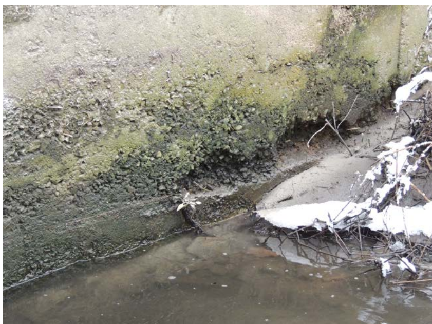
Narušený beton pravé opěrné stěny
