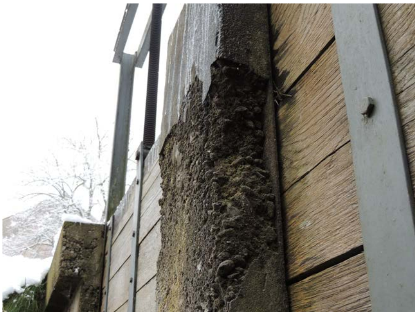
Narušený beton stěny mezi stavidly
