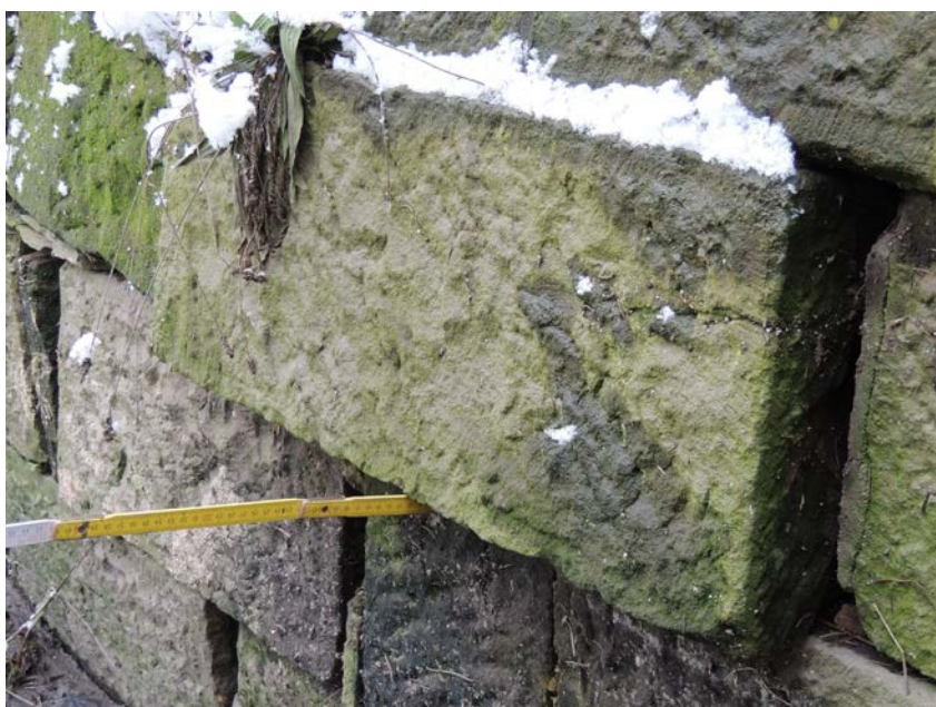
Uvolněné kameny levé opěrné zdi
