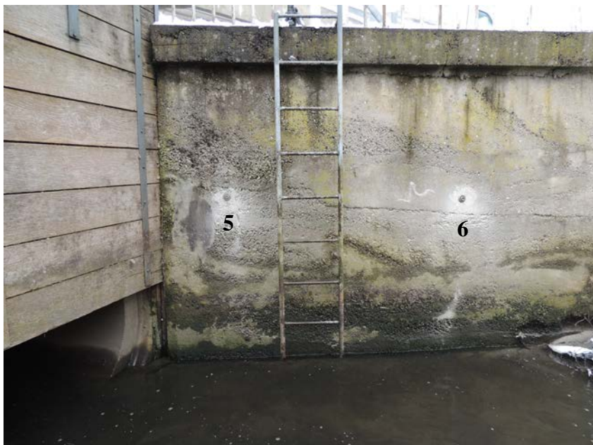
Pohled na místa zkoušek soudržnosti betonu na pravé opěrné stěně
