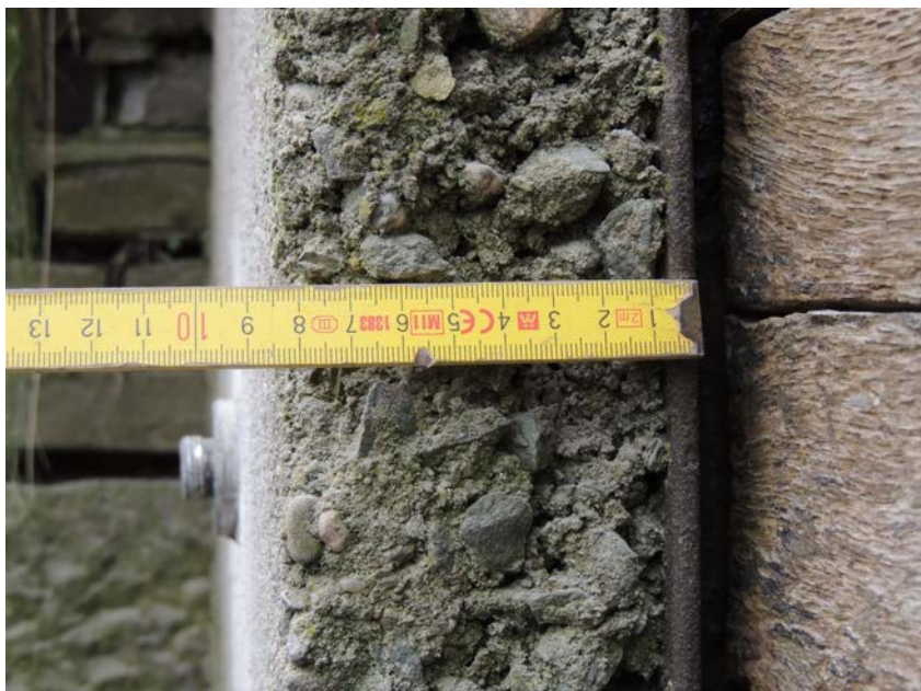
Tloušťka betonu stavidlové stěny nad ocelovým vodícím profilem
