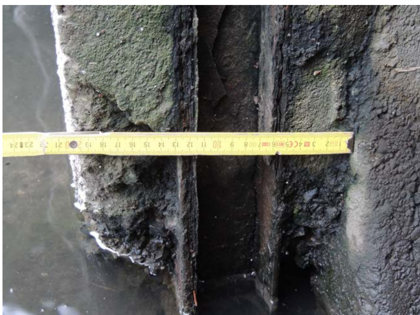
Skladba stavidlové stěny od odtokové trubky (vpravo) k vnějšímu líci
