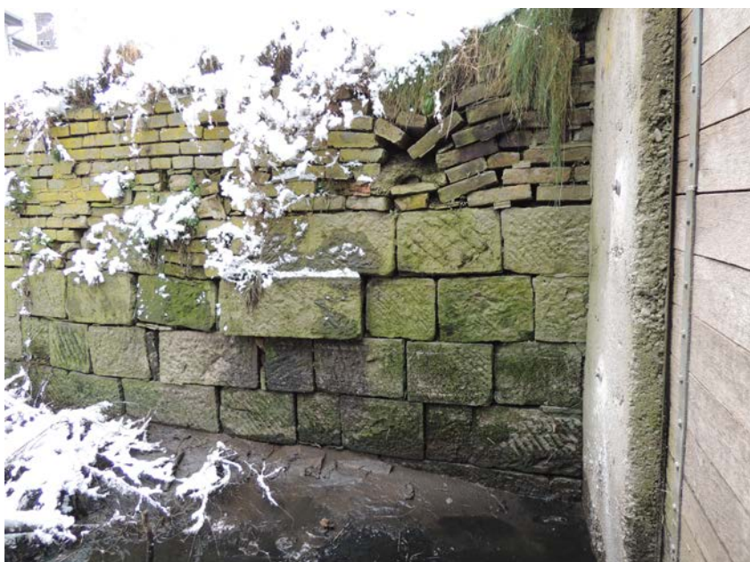
Uvolněné kameny levé opěrné zdi
