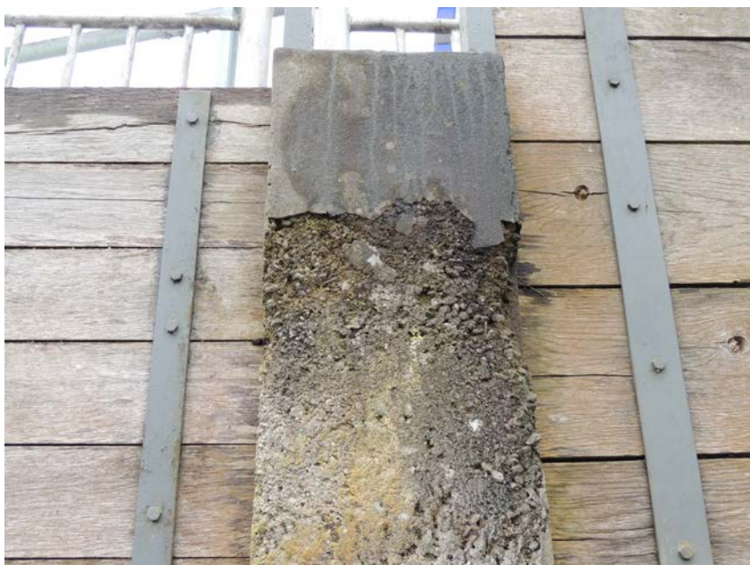
Narušený povrch betonu stěny mezi stavidly
