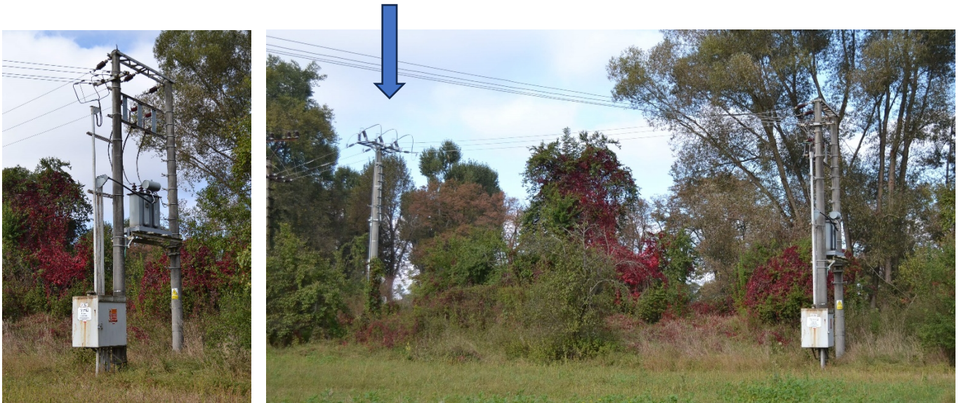
Stožár pro napojení kabelové vn přípojky a sloupová TS – stav 7.10.2016
