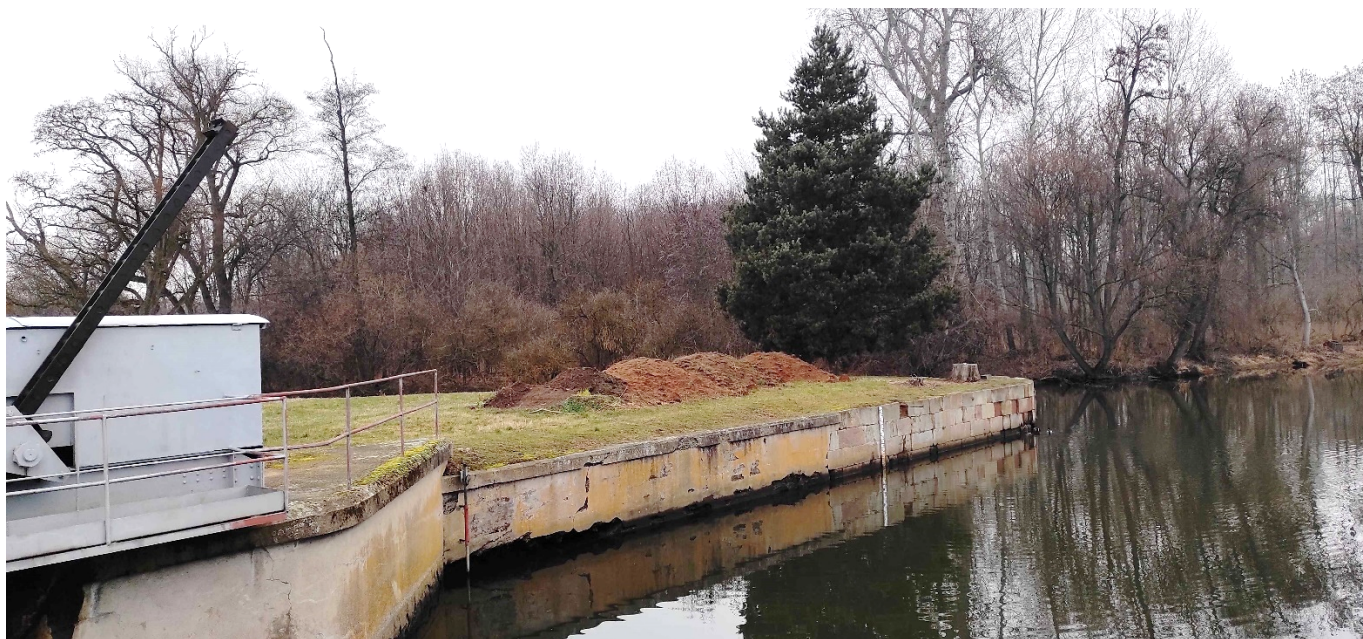
Obr. 2: Stav v lednu 2022 – plovoucí norná stěna na vtoku do náhonu již byla odstraněna.
