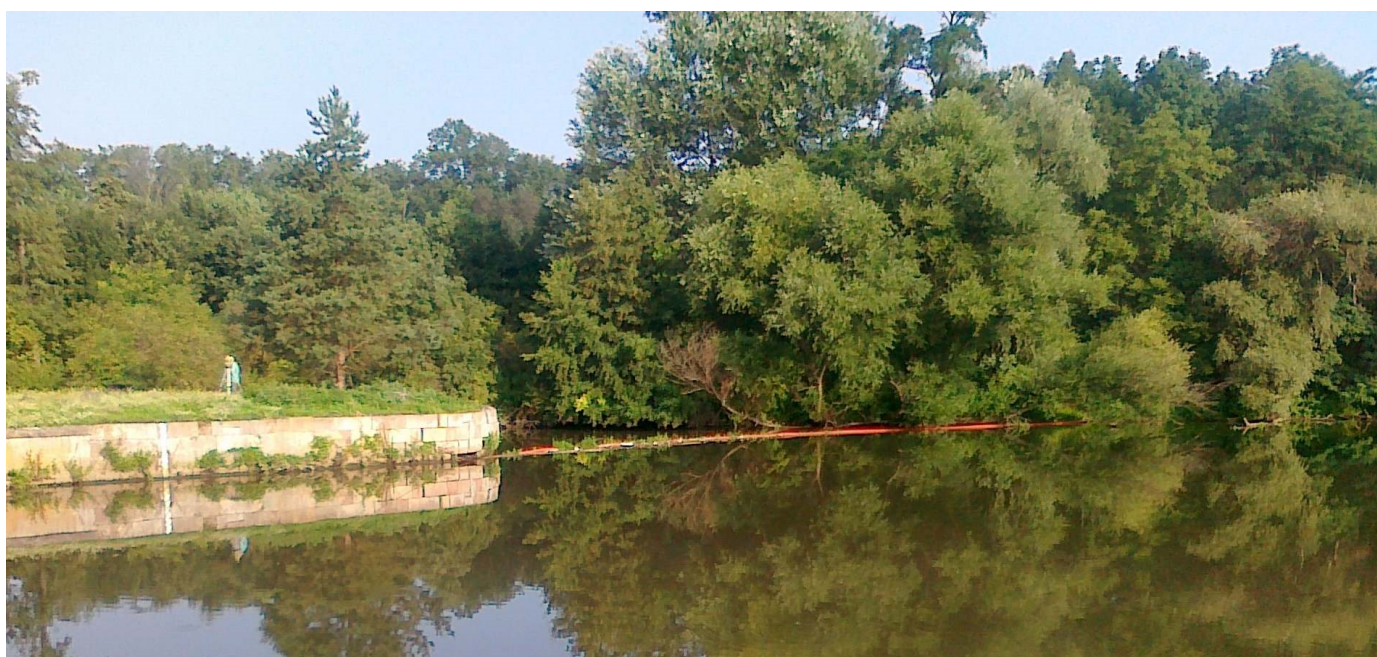
Obr. 3,4,5: Původní plovoucí normá stěna osazená na vtoku do náhonu – stav v roce 2016.
