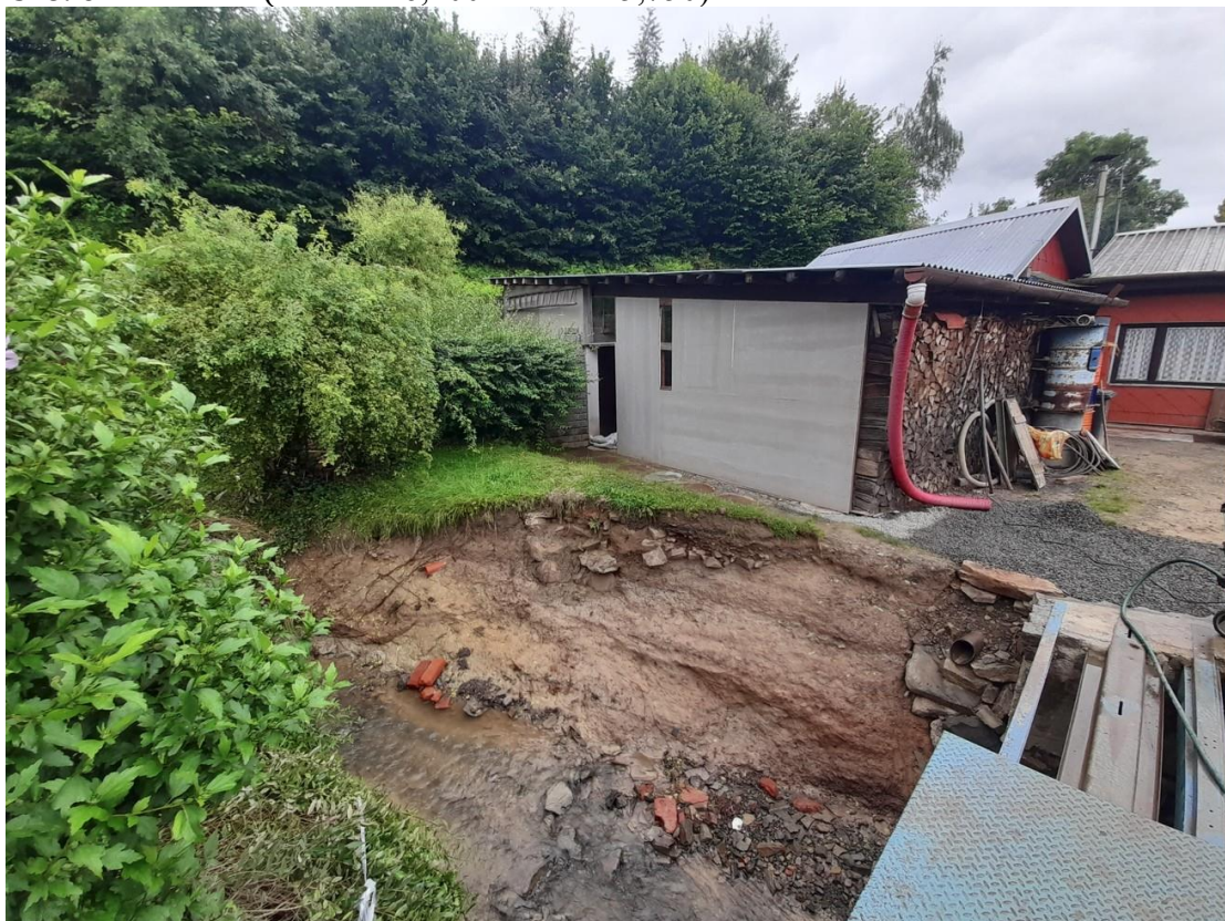
Hlinsko: dolní úsek – (od ř. km 6,100 do ř. km 5,750)
