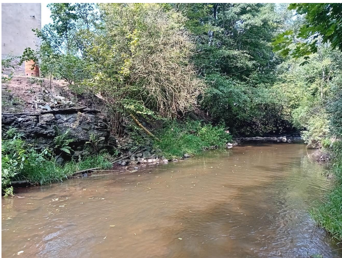
SO 02 – stávající poškozené břehové opevnění
