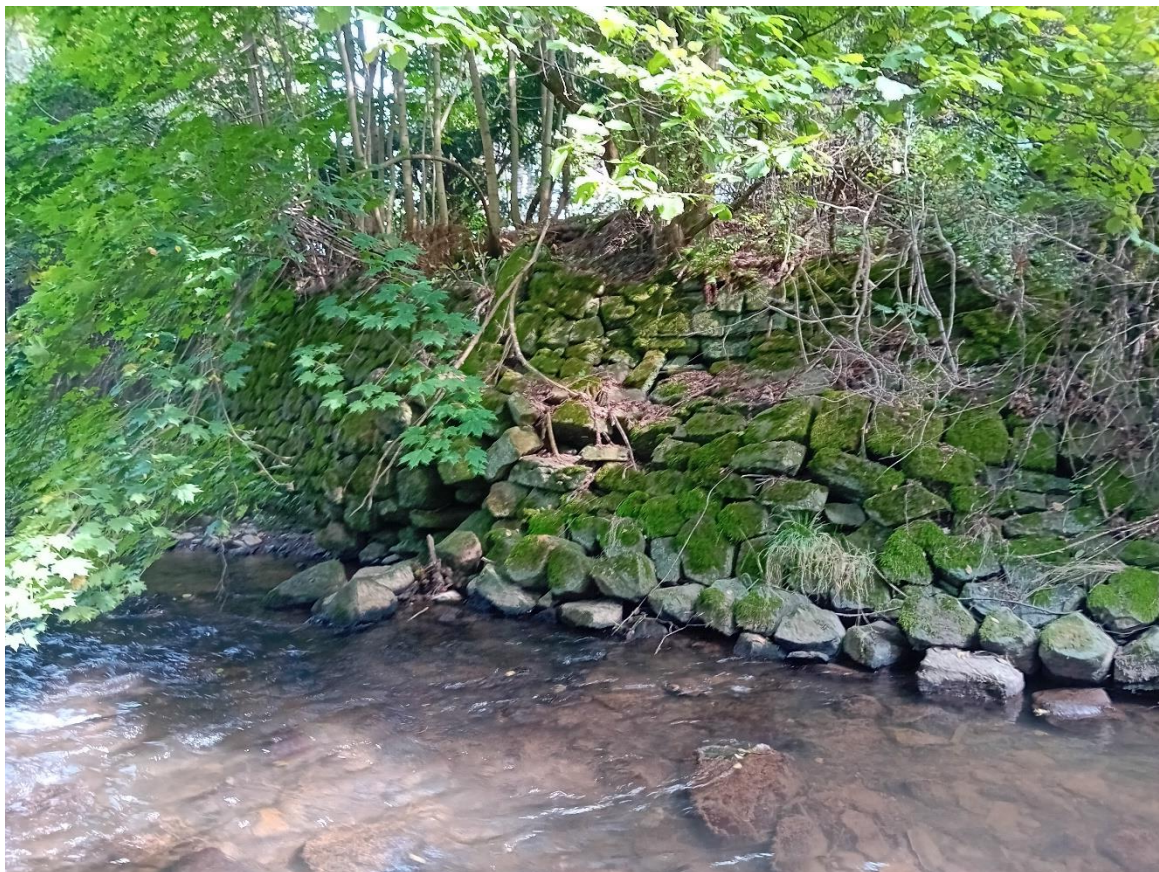
SO 02 – stávající poškozené břehové opevnění
