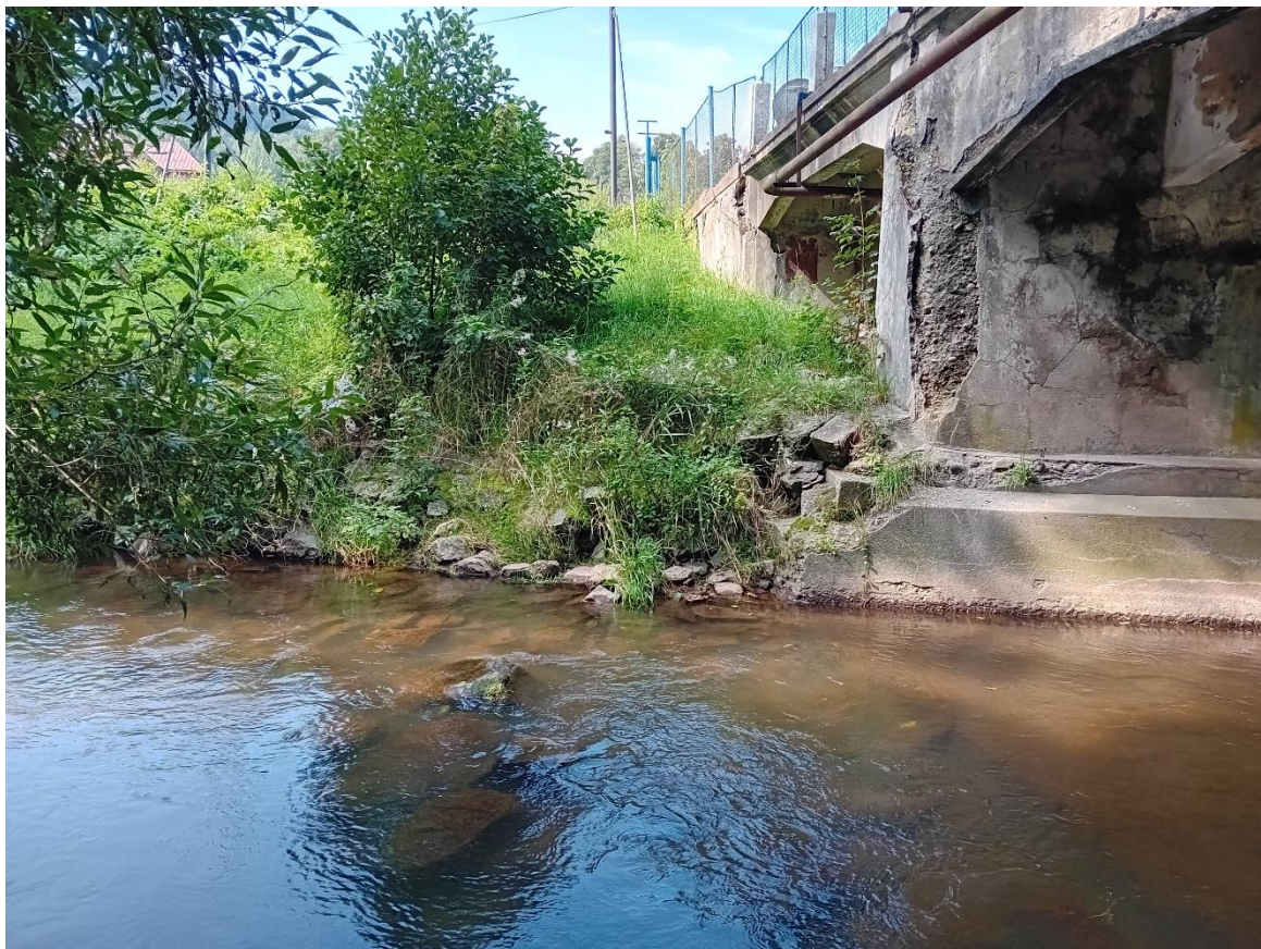
SO 02 – stávající poškozené břehové opevnění
