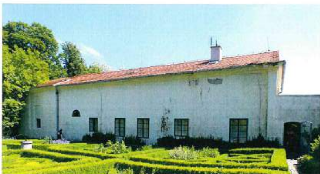
Západní průčelí západního křídla kočárovny (K) při zámku Kačina. Z původního symetrického klasicistního řešení se zachoval jen levý rizalit a jediné polokruhové okno rovněž vlevo. V původním řešení byl vpravo stejný rizalit a plochu mezi rizality členila jen polokruhová okna
