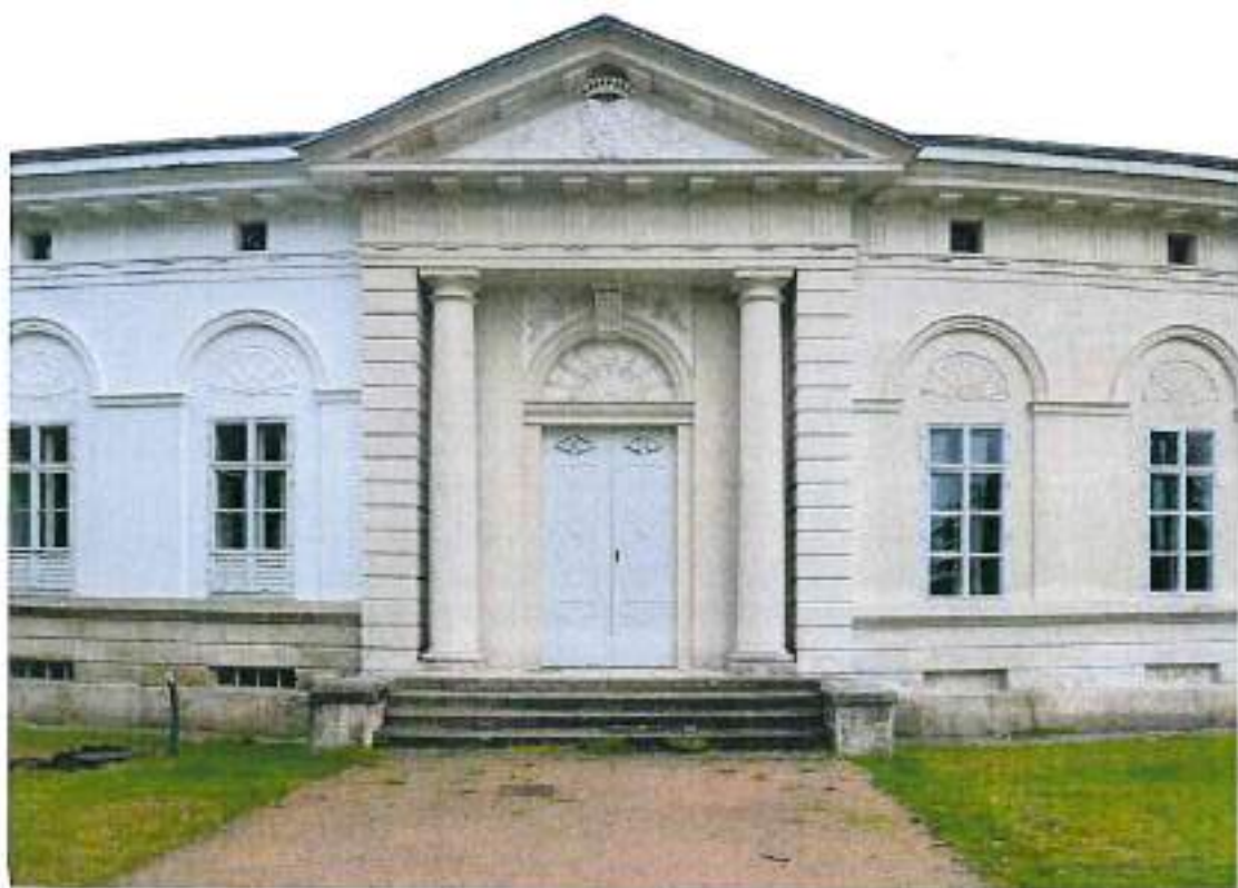
Pohled na zahradní fasádu jižního kolonádového křídla (B) zámku Kačina od západu s architektonizovaným vstupem do střední chodby křídla. Na rozdíl od pavilonu je zde použito římsko-dórkého řádu
