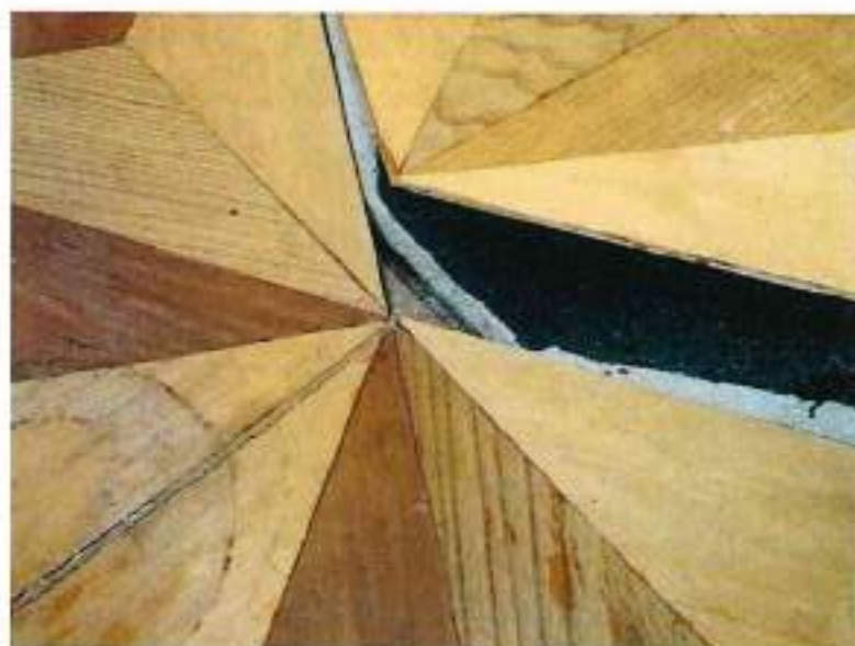
Nevhodné uložení nových intarzovaných šablon na OSB desky
