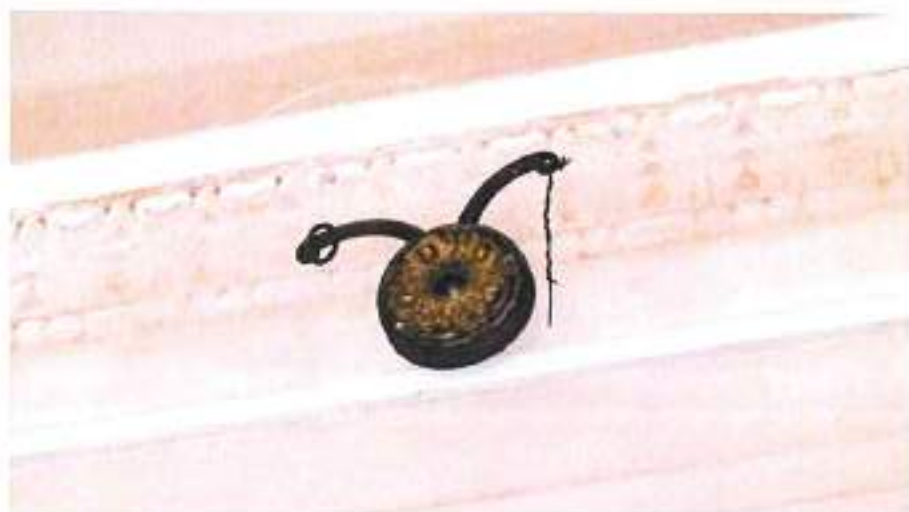
Mechanismus zvonku v místnosti C 126, páčka vlevo sloužila k zavěšení stuhy s třapcem na konci, vpravo pak bylo drátěné táhlo vedoucí k dalšímu převodnímu mechanismu a dále do pokoje služebnictva
