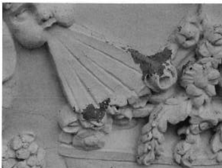
Detail poškození štuky – praskliny a narušená modelace
