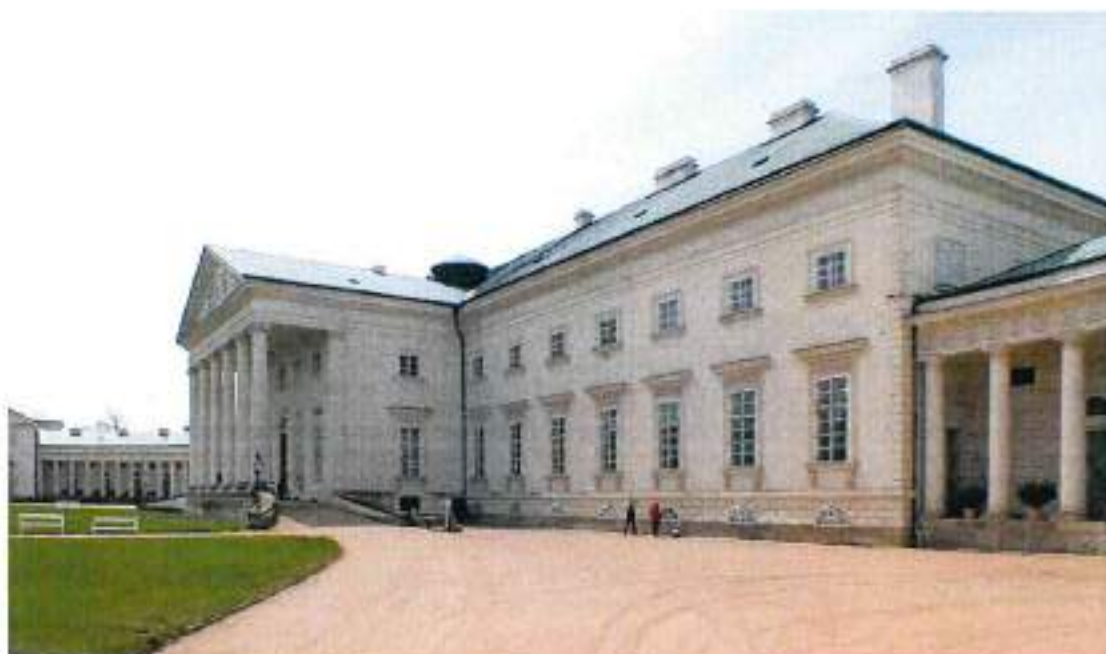
Pohled na corps-de-logis (C) zámku Kačina od severovýchodu ukazuje významný výškový rozdíl hlavní budovy od ostatních partií zámku. V souladu se suprapozicí řádu je u průčelního portiku použito iónského řádu, v hierarchii řádů vyššího
