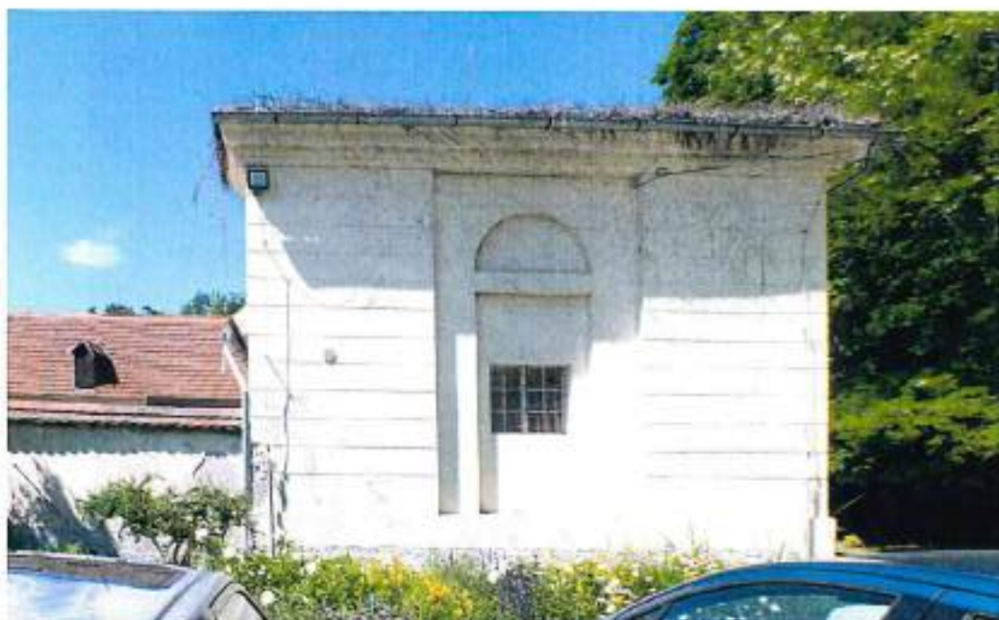
Východní průčelí severního křídla kočárovny (K) při zámku Kačina. Pouze okenní otvor je mladším doplňkem původního klasicistního řešení
