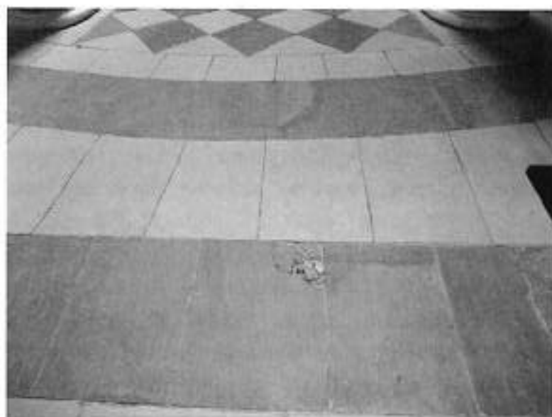
Poškození mozaiky v knihovním pavilonu
