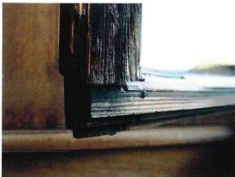
Typické poškození okenního křídla
