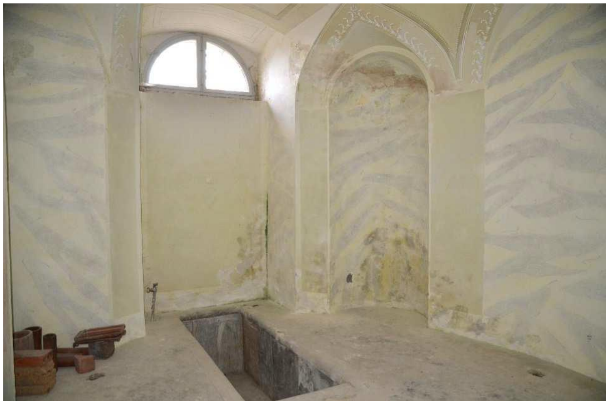
Obrázek 4 Historická koupelna se zapuštěnou vanou (bude restaurována) v 1. PP
