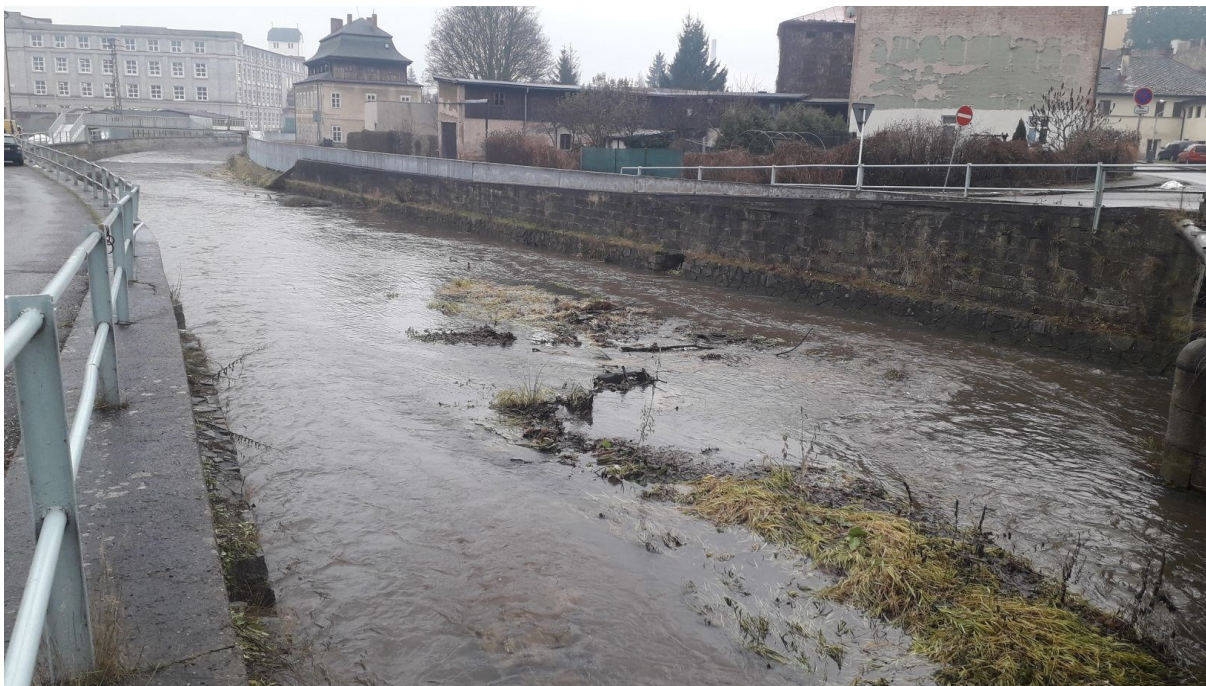
Pohled po proudu od ř. km 35,500
