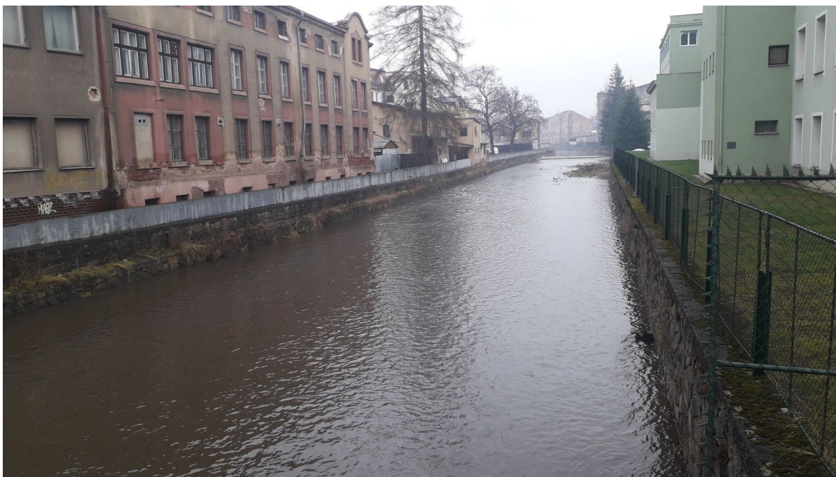
Pohled po proudu od ř. km 35,621
