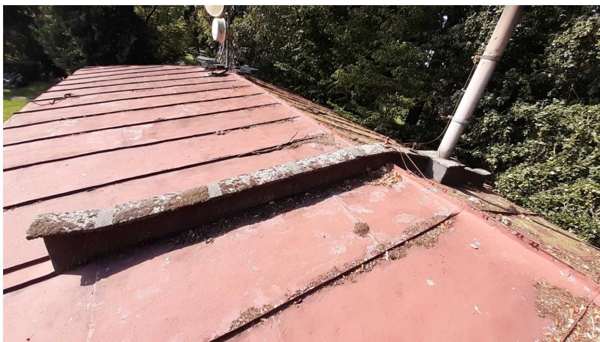
Detail zdi a komínu
