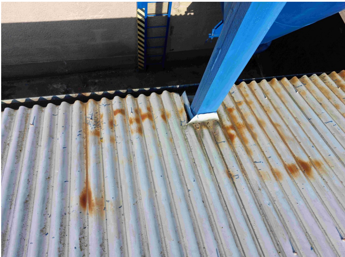
Detail prostupu odlučovače plyn střešní krytinou
