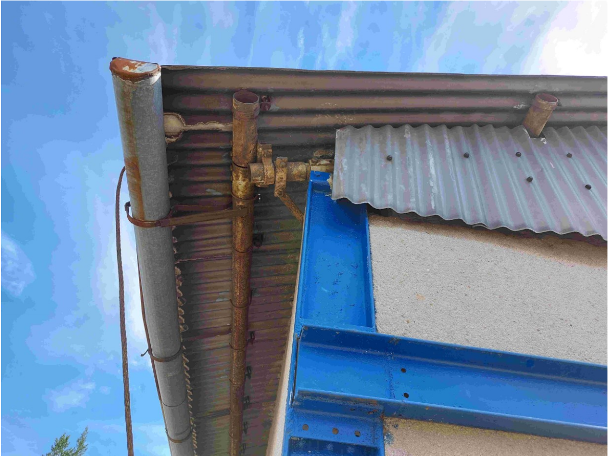
Z venku viditelné části trubkových nosníků určených k očištění a nátěru
