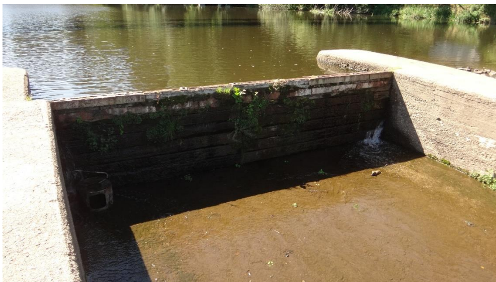
Pohled na hrazení vorové propusti
