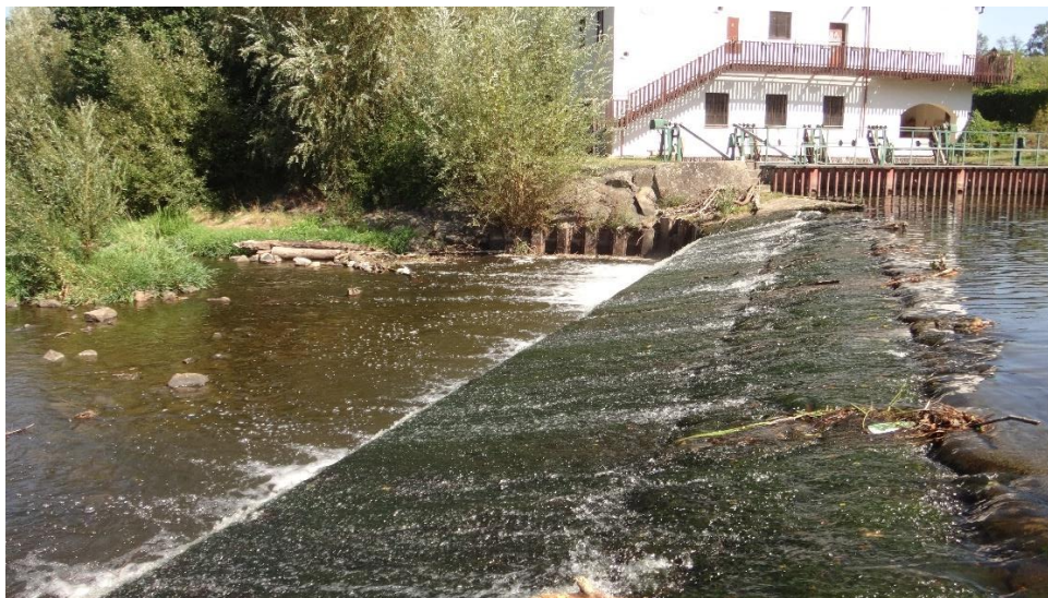
Pravé pole – pohled od vorové propusti k MVE
