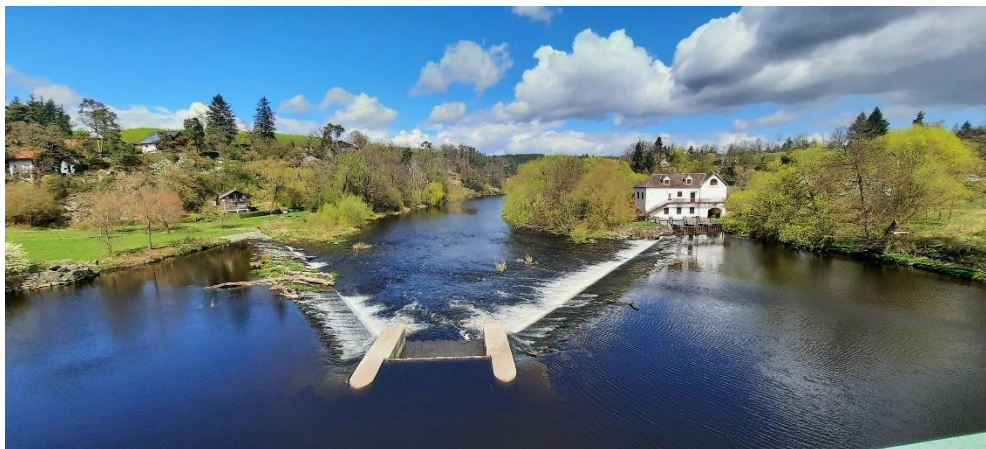
Pohled z lávky pro plynovod v nadjezí (shybka plynovodu nově pod korytem)
