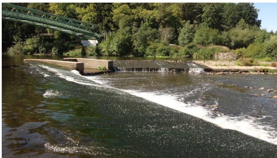
Pohled na vorovou propust a levé pole
