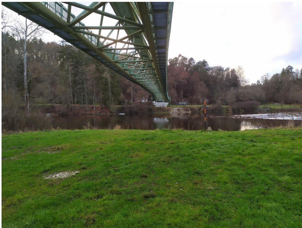
Pohled z levého břehu v trase shybky plynovodu
