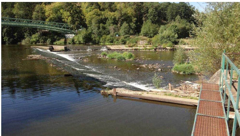
Pohled na pravobřežní zavázání, kde bude umístěn vtok do RP
