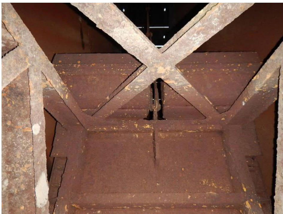
Průhled segmentem na přídavná závaží a ukotvení ovládacích táhel
