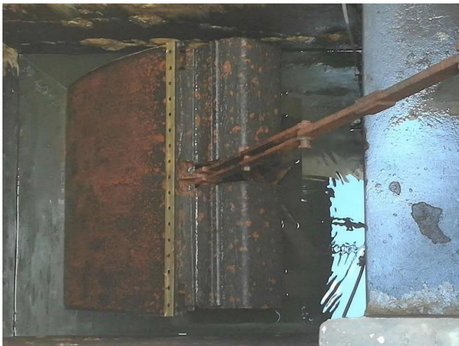
Pohled z plata šachtou na segment v horní poloze
