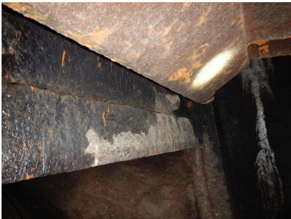
Pohled horní těsnící práh rámu a dolní hranu segmentu v horní poloze
