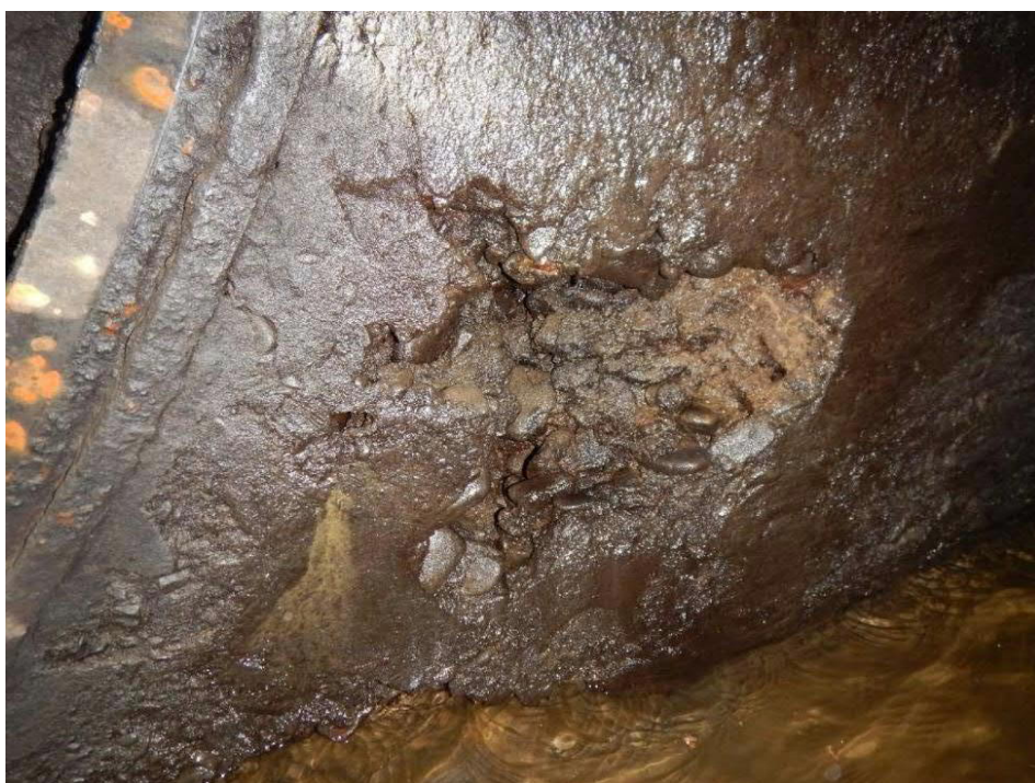
Pohled na lokální poškození zdi obtokového tunelu
