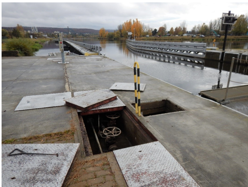
Pohled na plato PK u horních vrat – vstup do šachty a odkrytý žlab hydraulického potrubí s regulačními prvky
