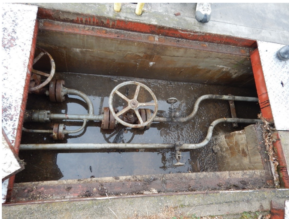
Pohled na žlab hydraulického potrubí s regulačními prvky
