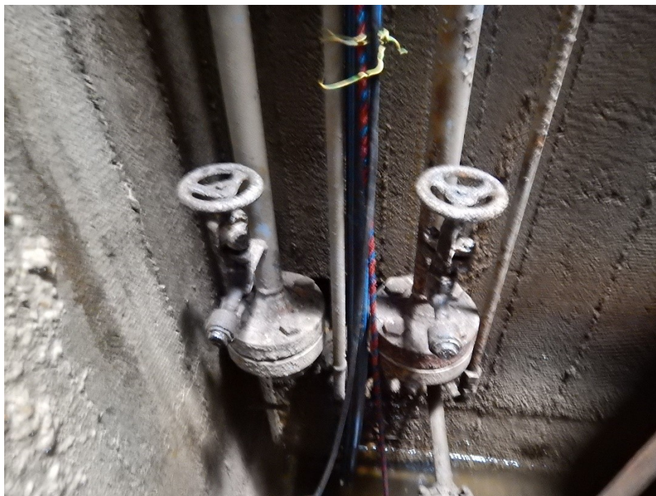
Pohled na koncové příruby vypouštěcí ventily v šachtě
