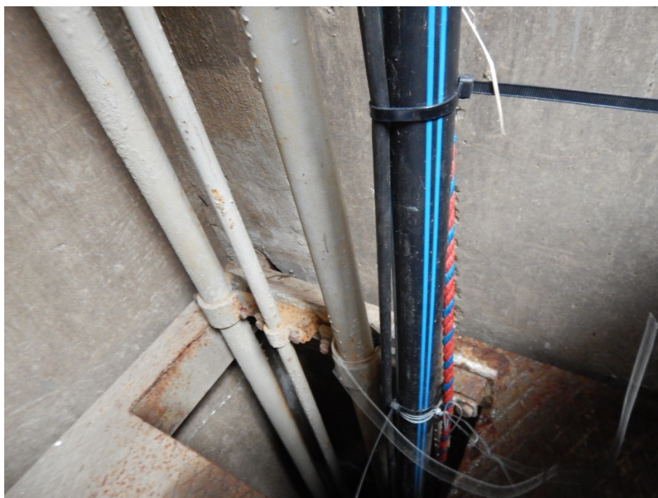
Detail průchodu hydraulických trubek podestou
