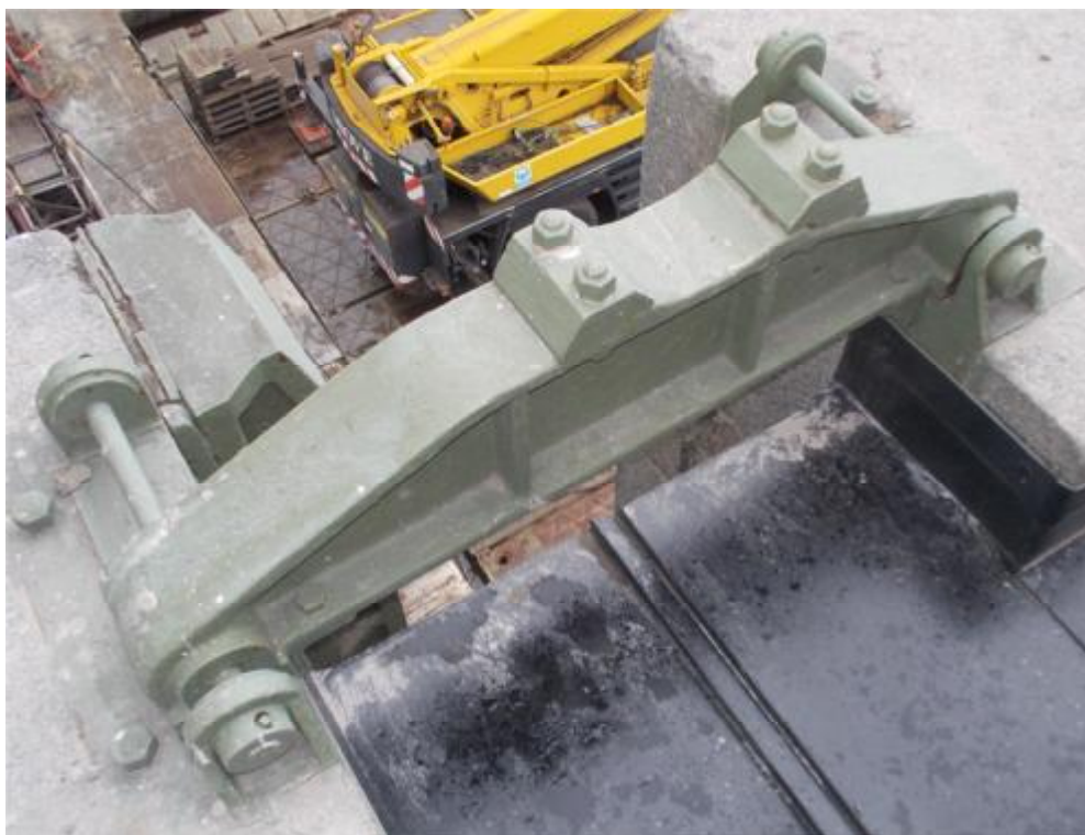
Opravený trámec horního hrazení VPK
