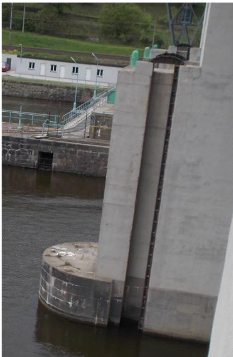
Pohled na návodní drážku horního PH
