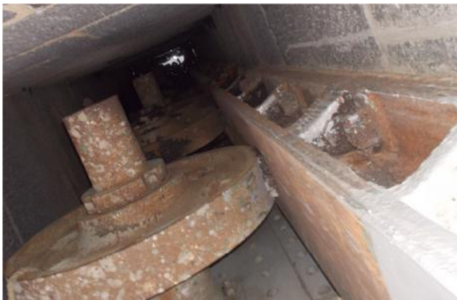
Stav opěrných kolejnic v drážce PH
