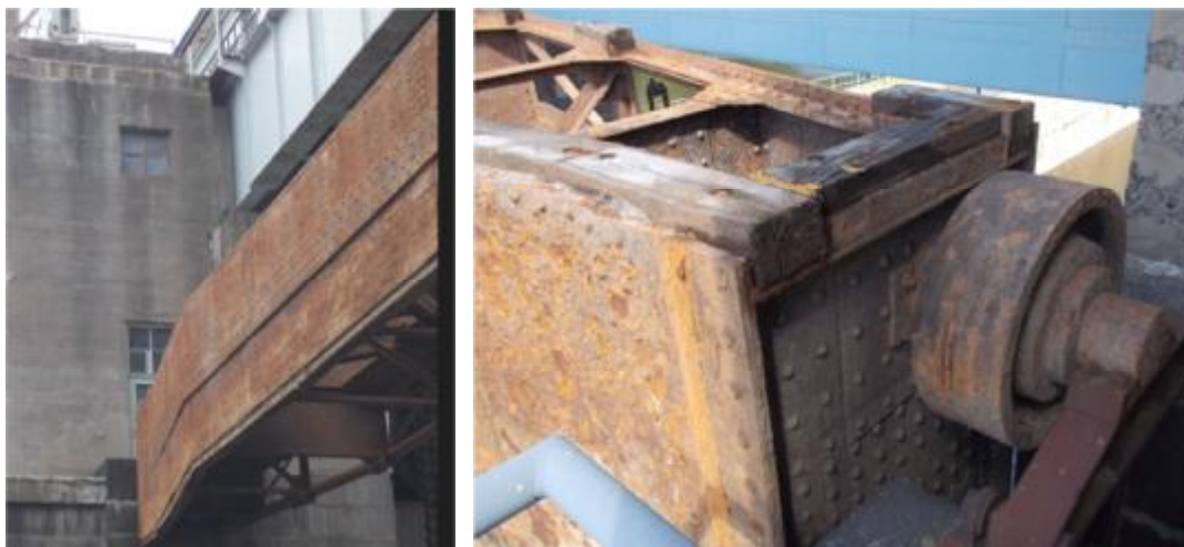
Fotodokumentace stavu ocelových konstrukcí hradel HPH
