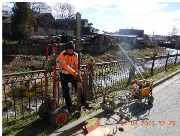
Obr. 3,4: Pohled k vj. na hloubení sondy S2a soupravou Argos-HH; Pohled k jv. na hloubení S2c pneumatickou Rammsondou v blízkosti DPH2.
