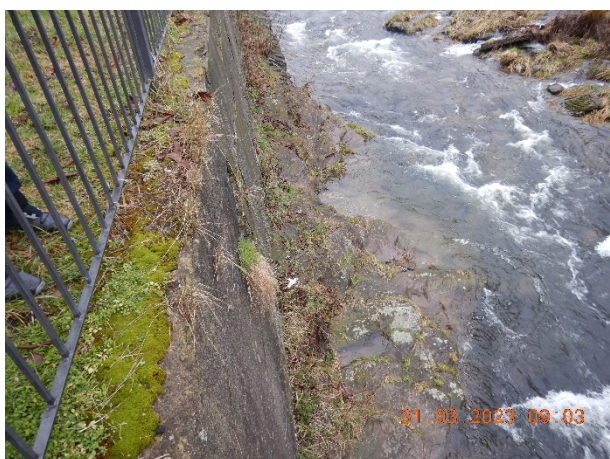
Obr. 9,10: Pohled z nábřeží proti proudu Labe na DB1; Detail kontaktu stěny a podložních hornin v místě DB1.
