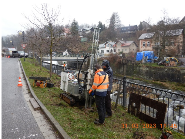
Obr. 5,6: Pohled k sv. na hloubení sondy (S2)A soupravou Argos-HH; Pohled k vj. na místo hloubení sondy (S2)E.
