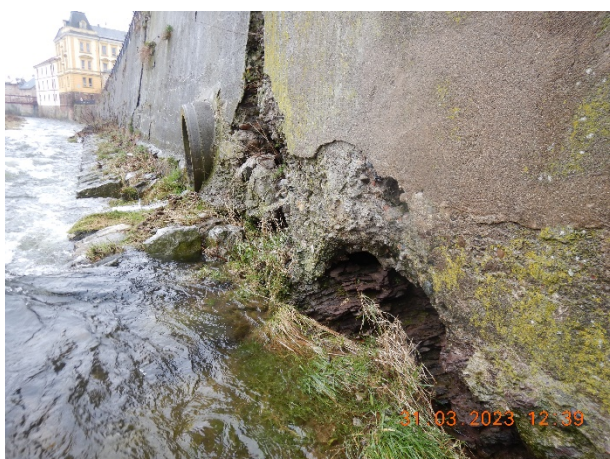
Obr. 11, 12: Pohled k jz., včetně detailu, na DB2 pod demolovanou lávkou, v pozadí výúst Zámeckého náhonu.
