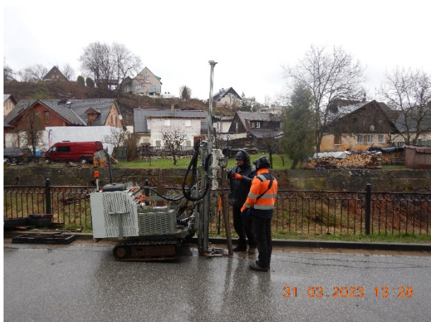
Obr. 3,4: Pohled k vj. na hloubení sondy S2a soupravou Argos-HH; Pohled k jv. na hloubení S2c pneumatickou Rammsondou v blízkosti DPH2.
