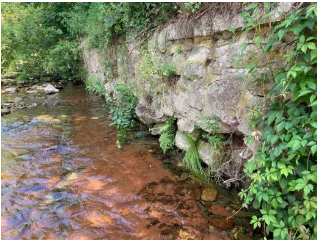
obrázek 3: vysunutá část zdi do koryta ve střední části úseku LB zdi
