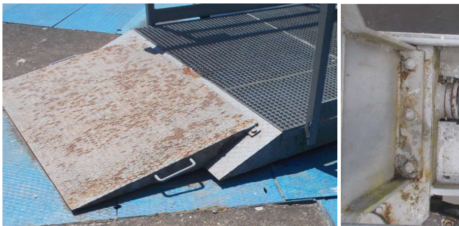
Detaily nájezdu na lávku a montáže k vratům, resp. odpružení
