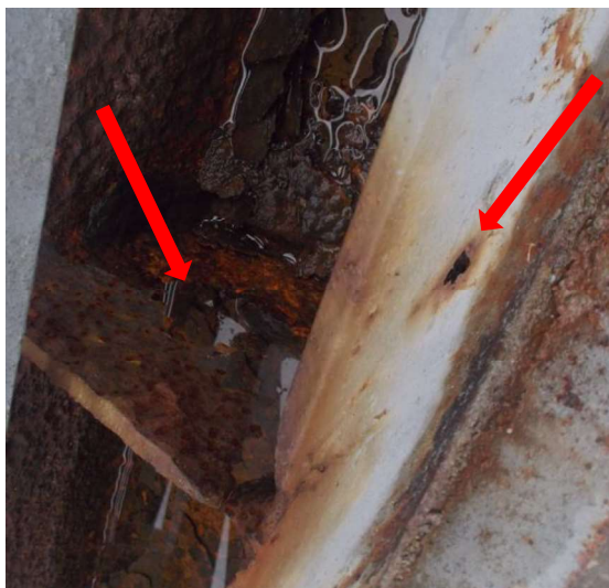
Silná koroze slupic (skrz konstrukci)
