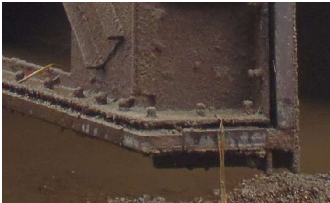
Technické řešení prahového těsnění na srazu
