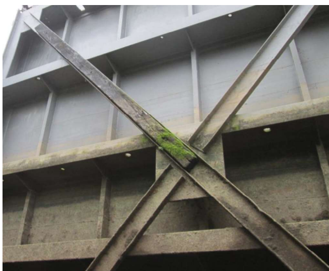
Poškozená, resp. chybějící výdřeva diagonál
