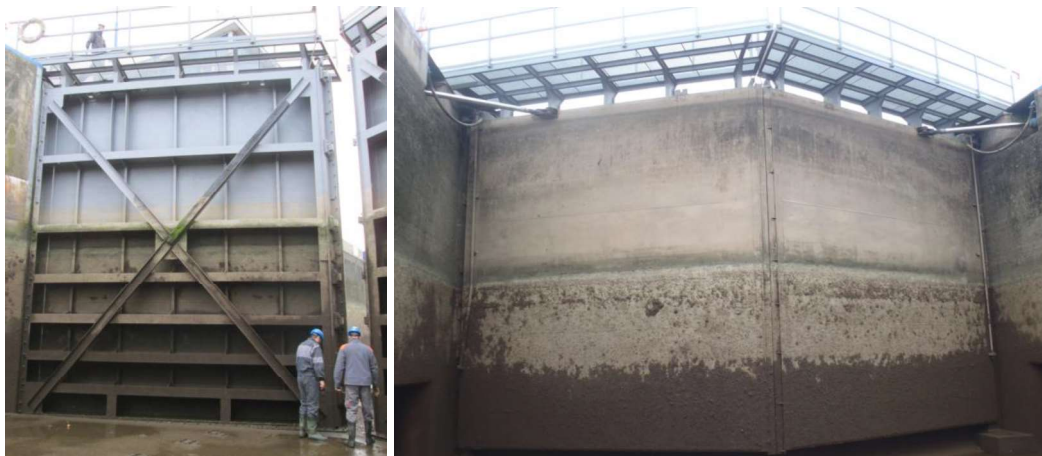
Konstrukce vzpěrných vrat zdola i shora
