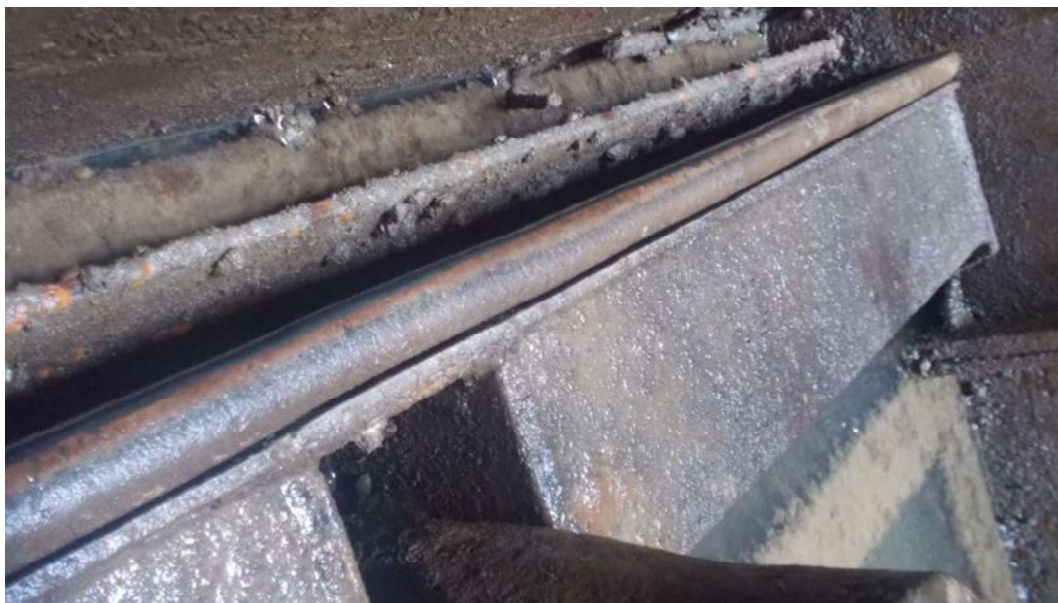
Těsnění tabule stavítka
