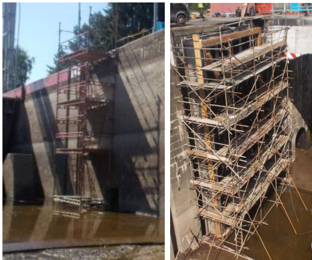
Realizace přístupových konstrukcí (příklad)
