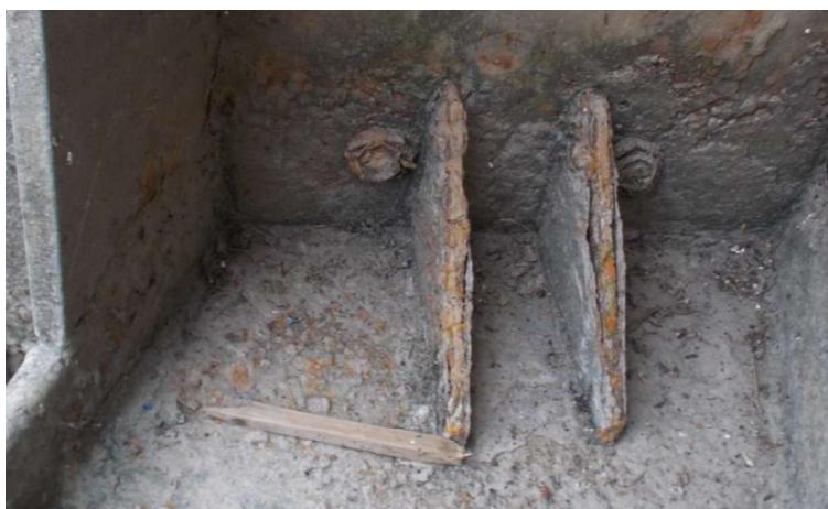
Poškozené výztuhy pod stoličkami, zkorodované šrouby stoliček
