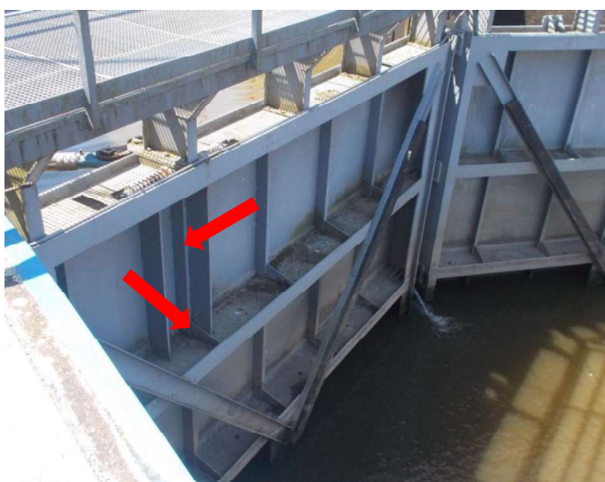
Zavaření spáry mezi ocelovými prvky
