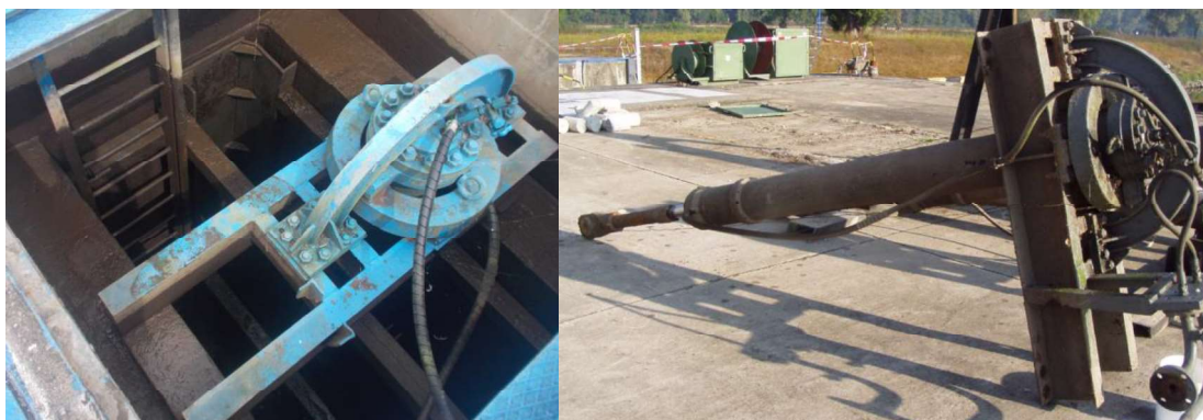
Pohon stavítka v šachtě a demontovaný na platě PK
