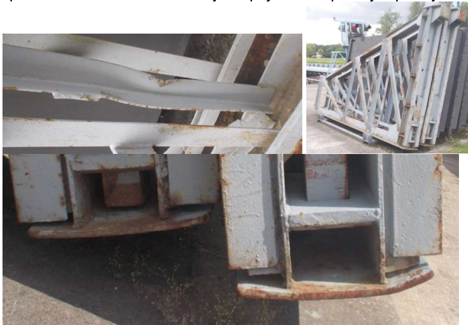
Příklady deformací dílů slupice, tvar
