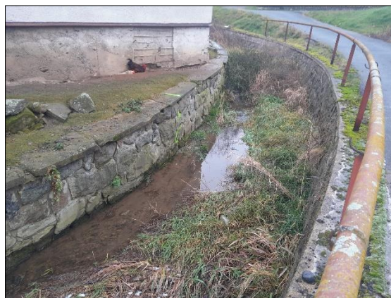
Kapacitní úsek toku protékající v opěrných zdech
