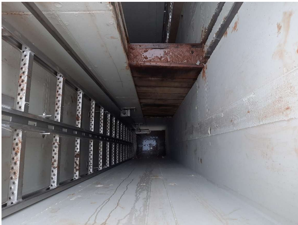
Typový nerezový žebřík s protipádovou kolejnicí
