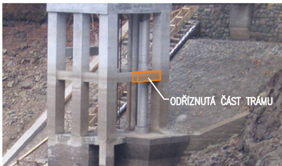
Obrázek - návrh odříznuté části trámu
