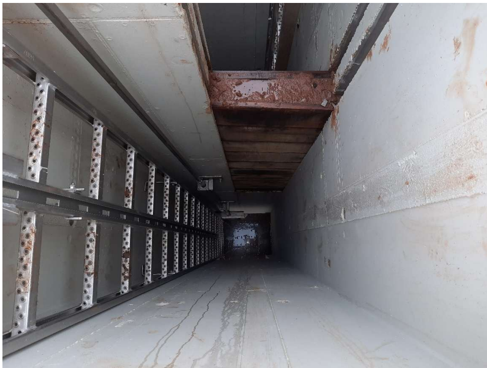
Typový nerezový žebřík s protipádovou kolejnicí
