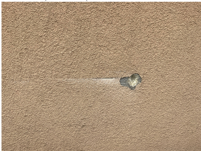
Obr.4-lokální poškození v ploše
