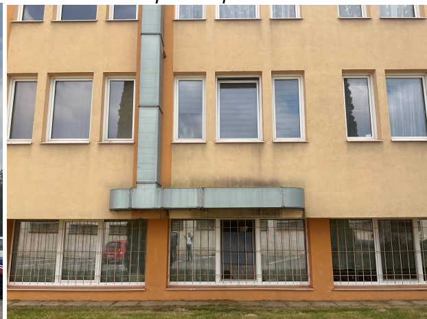
Obr.2-biotické napadení povrchu
