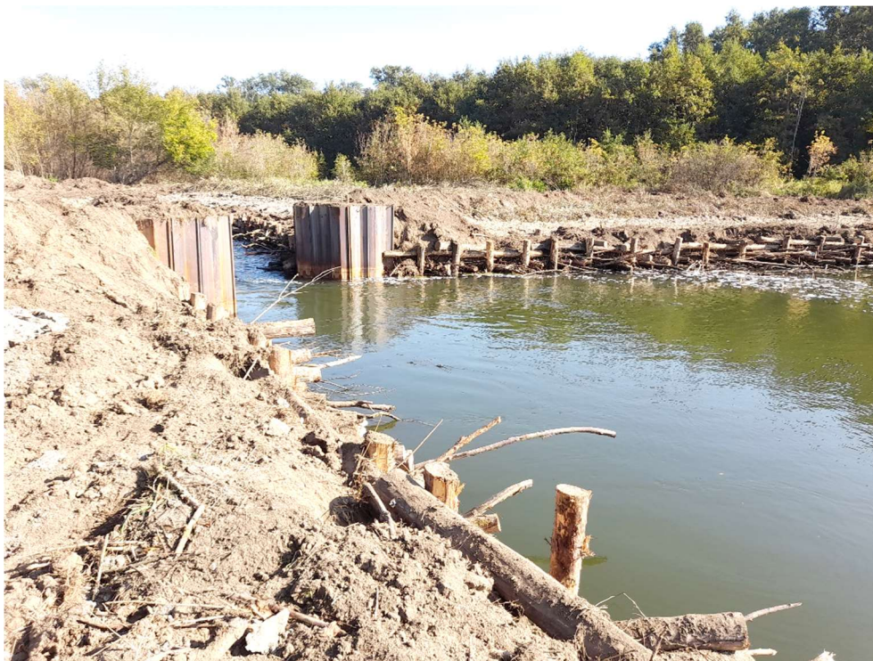
Obr.4 – rozdělovací objekt – štětové pole bude přisypáno zeminou po vzoru Rakouské strany
