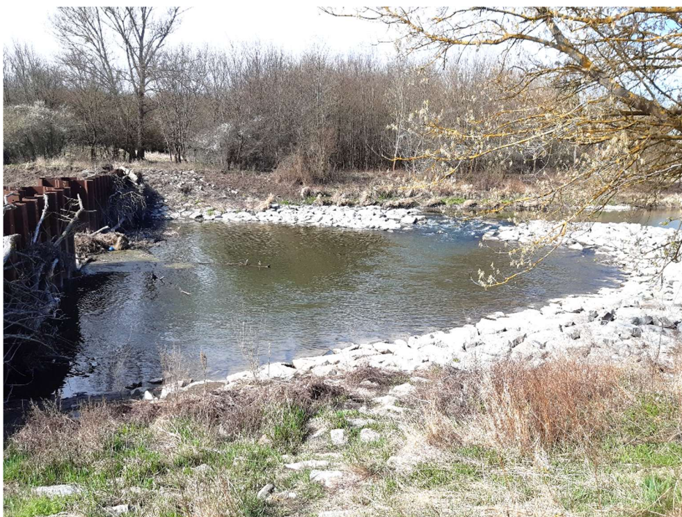
Obr.3 – Rozdělovací objekt bude tvořen ze 2 částí – na obrázku balvanitý stupeň
