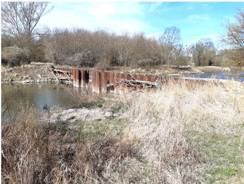
Obr.2 – Rozdělovací objekt bude tvořen ze 2 částí – štětové pole se škrticím otvorem a balvanitý stupeň – na obrázku štětovnicové pole u ramene D18
