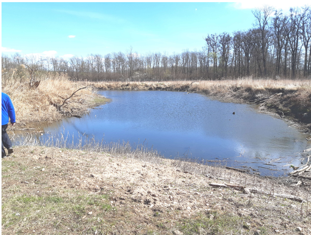
Obr. 1 – Pohled na odstavené rameno D13 – prokopnutí zemního piliře mezi řekou a odstaveným ramenem
