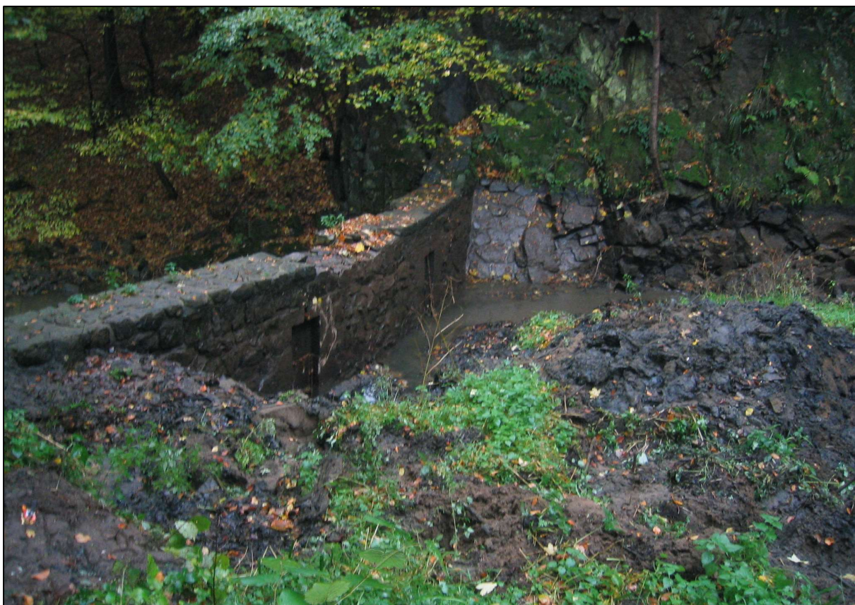
Obr. 3: Přehrážka v řkm 3,500, stav rubu tělesa při těžení sedimentu v r. 2004 (21.10.2004)
