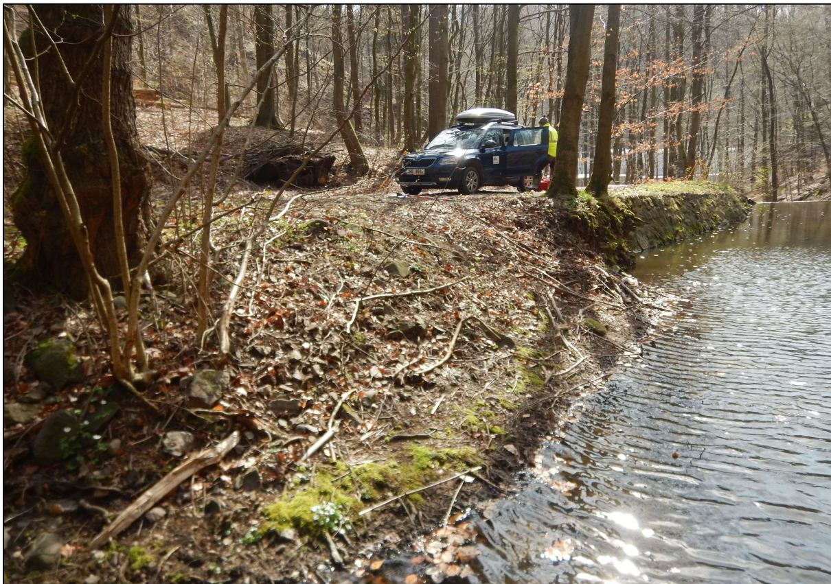
Obr. 10: Sjezd pro techniku a LB opěrná zeď z LK v zátopě přehrážky (26.3.2024)
