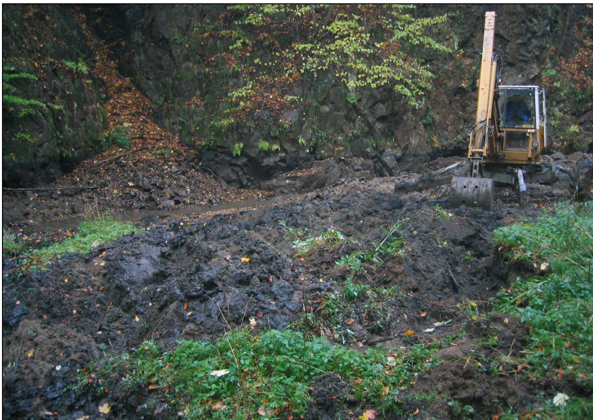
Obr. 4: Přehrážka v řkm 3,500, stav nádrže při těžení sedimentu v r. 2004 (21.10.2004)
