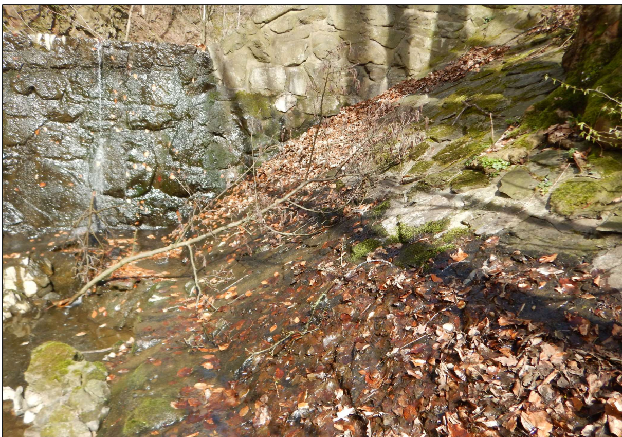
Obr. 9: Vývěry vody v dlažbě pod LB zavázáním přehrážky řkm 3,500 (26.3.2024)
