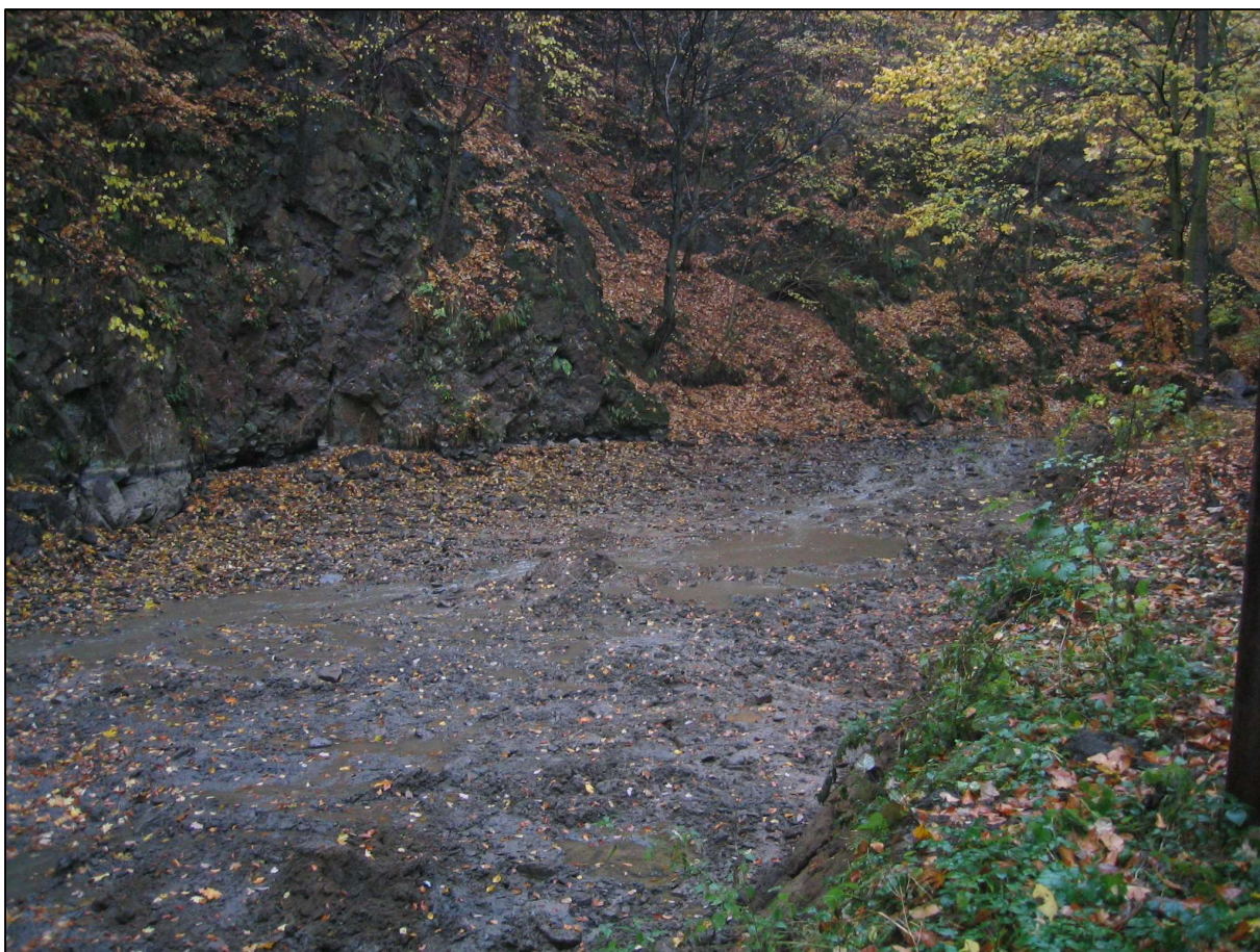
Obr. 5: Přehrážka v řkm 3,500, stav nádrže po odtěžení sedimentu v r. 2004 (27.10.2004)
