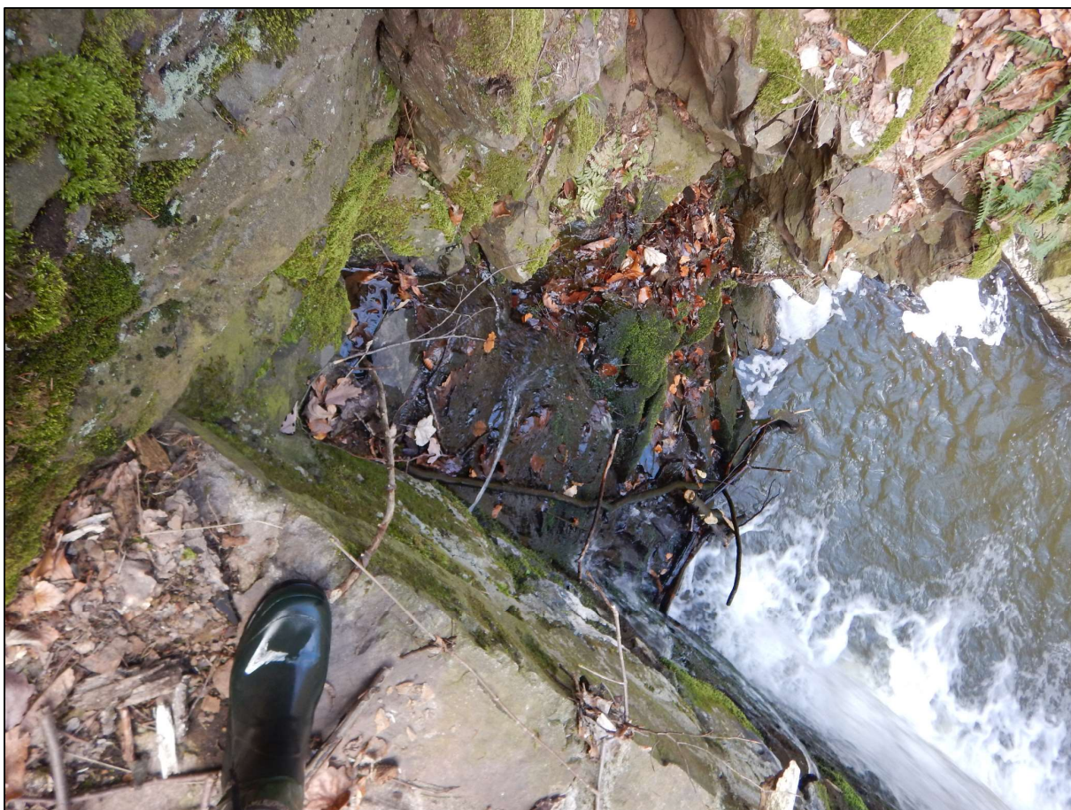
Obr. 13: Přehrážka v řkm 3,740, průsaky v LB zavázání (26.3.2024)
