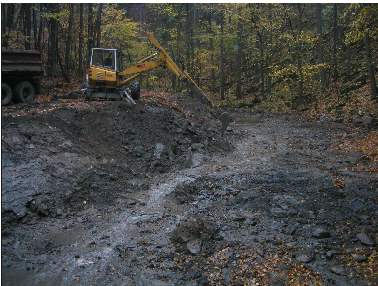
Obr. 16: Přehrážka v řkm 3,740, nádrž po odtěžení sedimentu (27.10.2004)
